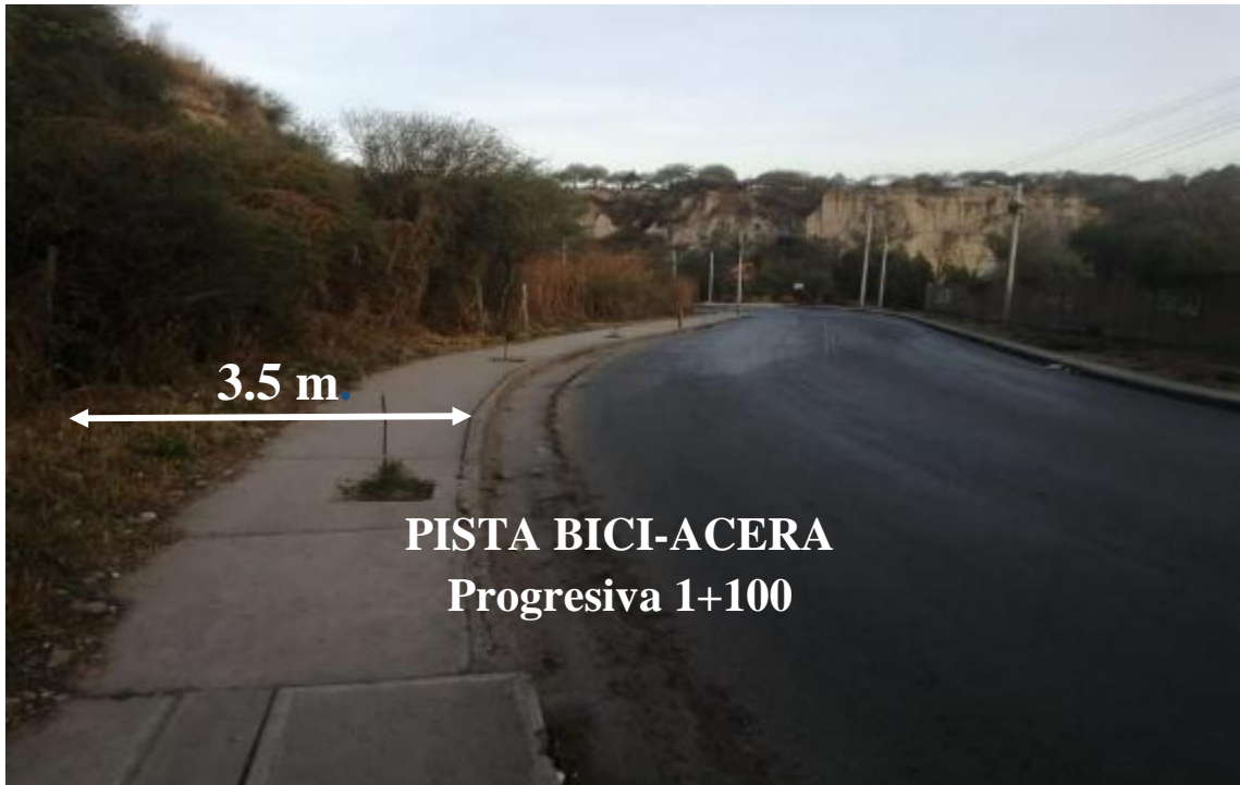
Gráfico 3. 23: Ancho de pista tramo 5, progresiva 1+100 (av. Luis de Fuentes)
