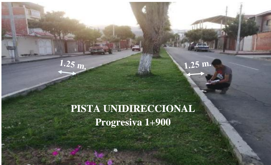
Gráfico 3. 26: Ancho de pista tramo 7, progresiva 1+900 (av. Horacio Aramayo)
