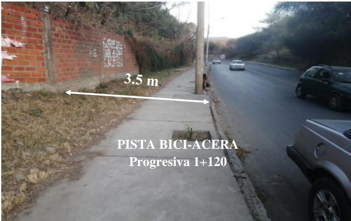
Gráfico 3. 24: Ancho de pista tramo 5, progresiva 1+120 (av. Luis de Fuentes)
