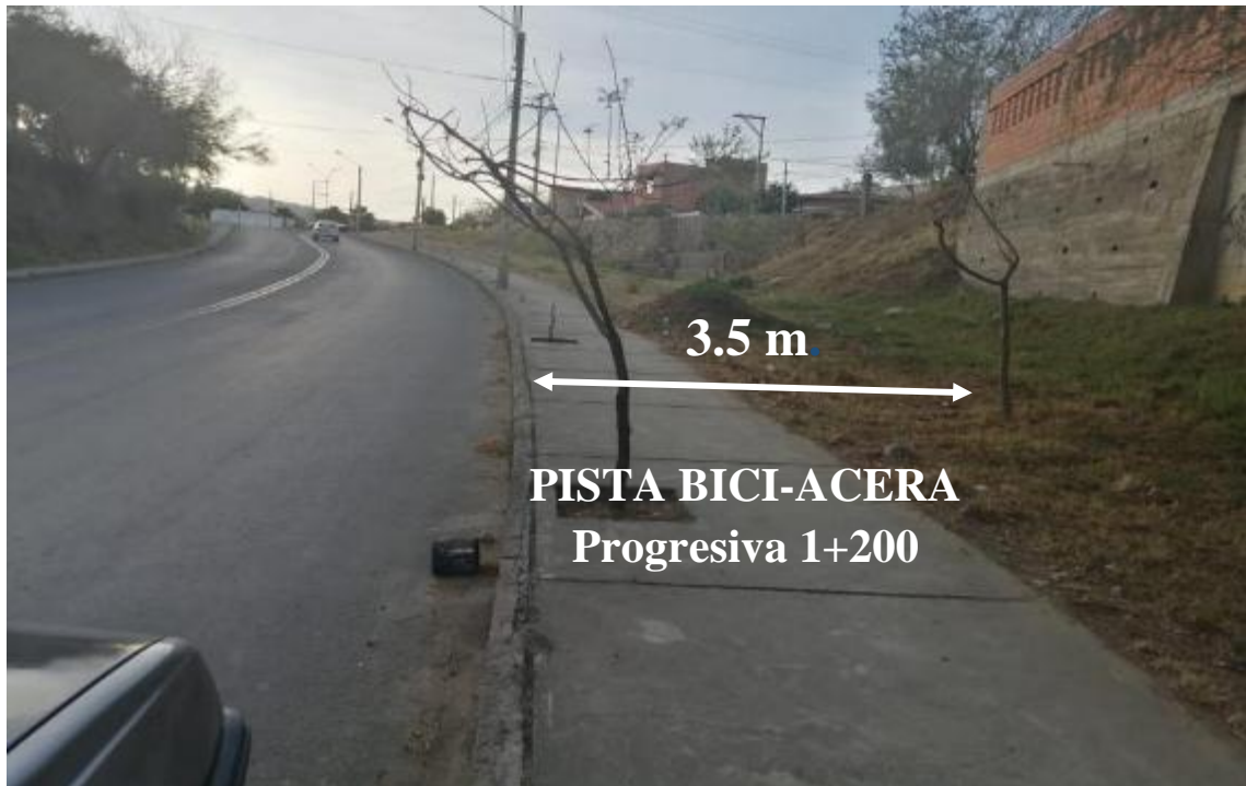
Gráfico 3. 25: Ancho de pista tramo 5, progresiva 1+200 (av. Luis de Fuentes)
