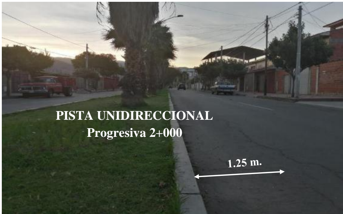
Gráfico 3. 27: Ancho de pista tramo 7, progresiva 2+000 (av. Horacio Aramayo)
