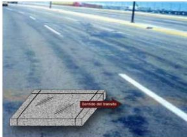
Figura 17. Pulimiento de la superficie.
