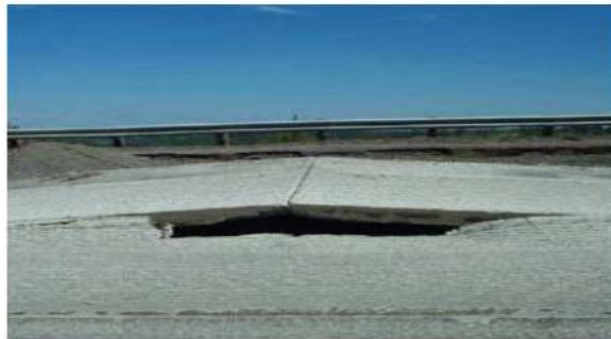
Figura 14. Levantamiento de losas en pavimento rígido.
