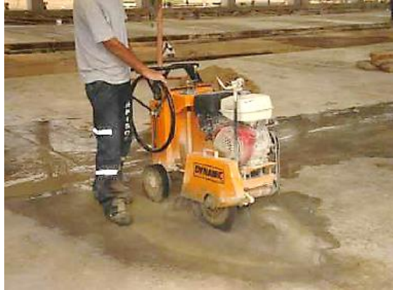
Figura 2.54. Trabajador con máquina para cortar el pavimento
