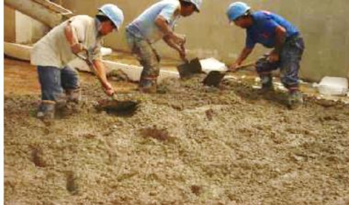
Figura 2.51. Obreros esparciendo el hormigón puesto en obra
