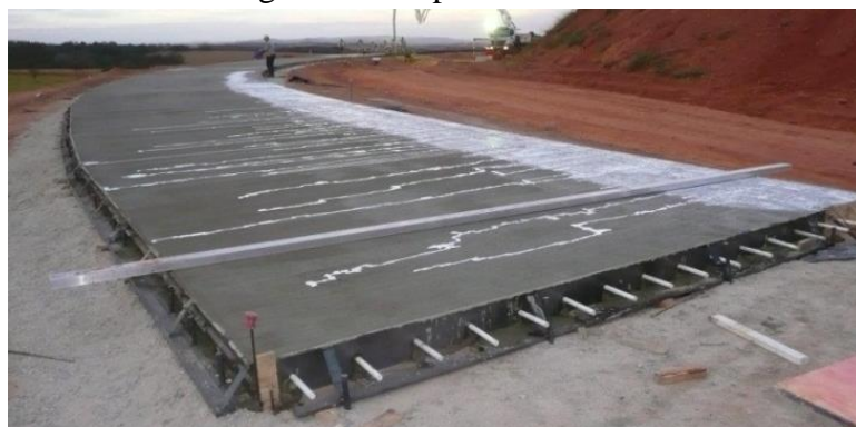
Figura 2.4. Capa de rodadura
