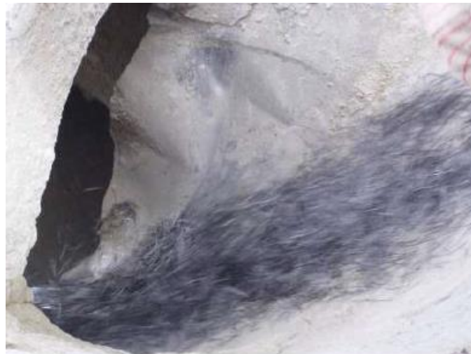
Figura 2.47. Fibras metálicas vaciadas por el tubo del mixer
