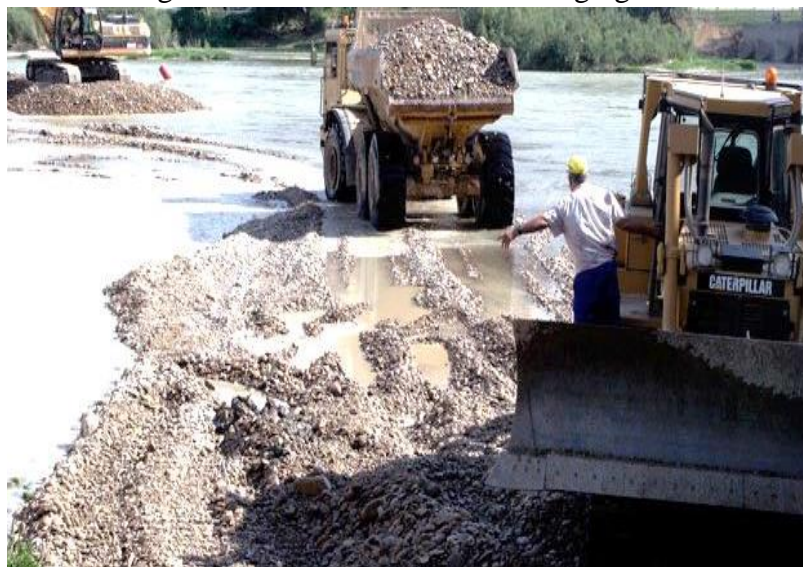
Figura 2.5. Extracción natural de agregados
