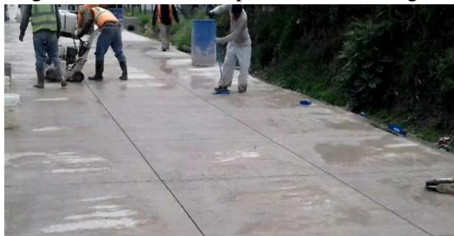
Figura 2.36. Curado del pavimento ultradelgado
