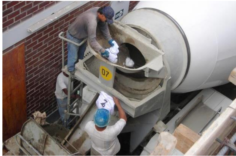
Figura 2.46. Vaciado de las fibras al mixer
