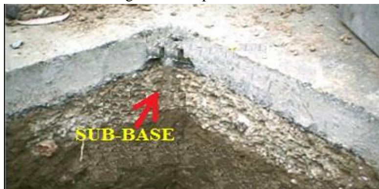
Figura 2.3. Capa sub-base
