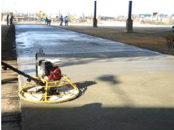
Figura 2.55. Maquinaria para realizar el pulido del pavimento
