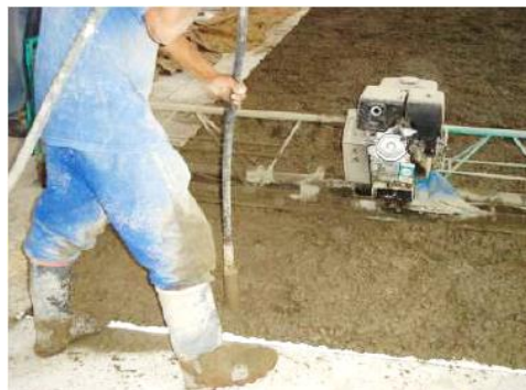
Figura 2.52. Obrero realizando el respectivo vibrado
