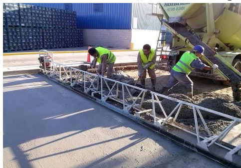
Figura 2.53. Nivelación de losa con maquinaria
