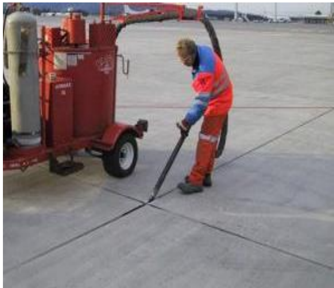
Figura 2.15. Obrero realizando el sellado de un pavimento
