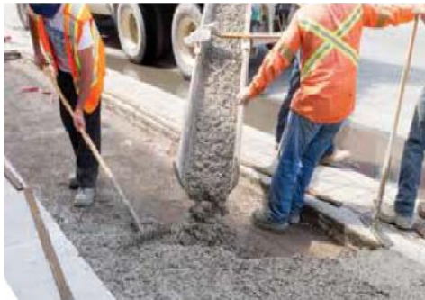
Figura 2.50. Personal realizando el vaciado de la mezcla en
