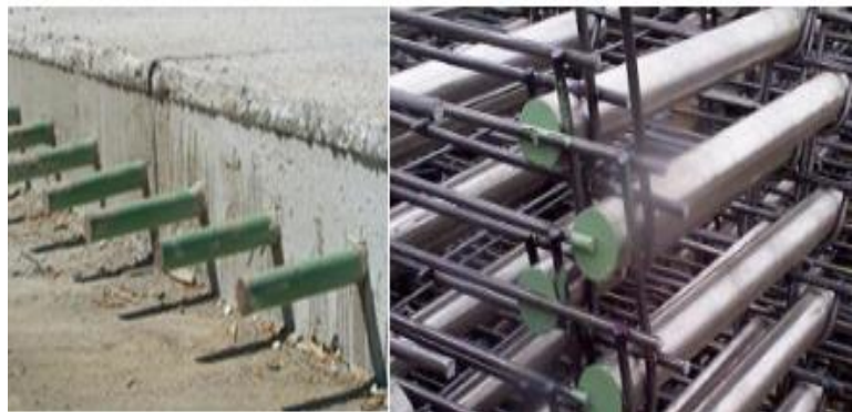
Figura 2.13. Junta de expansión
