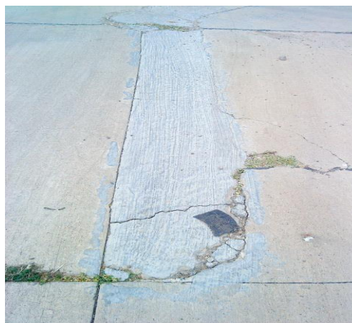
Parches en asfalto y concreto
