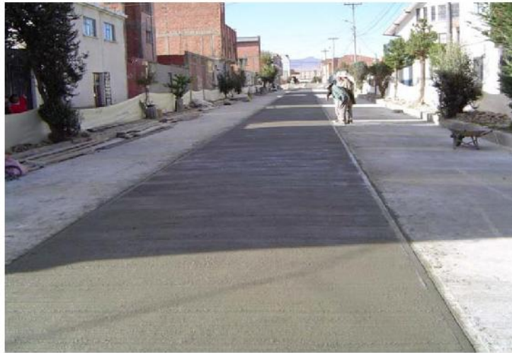
IlustraciónN°10. Junta longitudinal terminada
