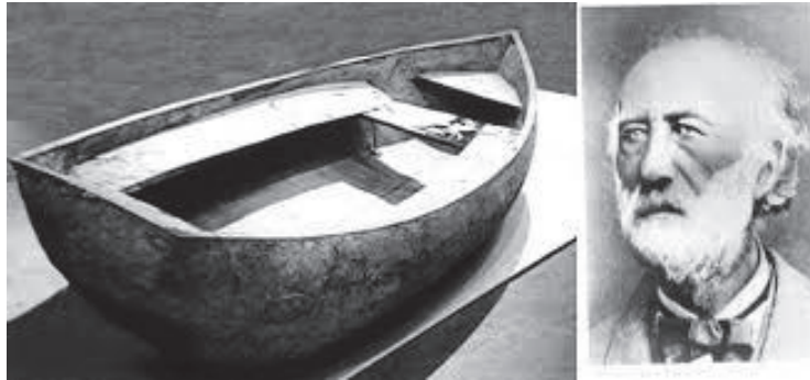
Figura 2. Bote de Hormigón Armado (Joseph Louis Lambot)
