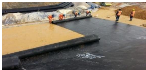
Fig. 14: Geomembrana puesta en obras
