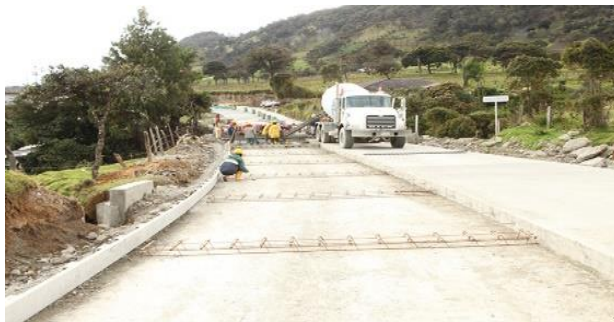
Fig. 9: Reparación de espesor
