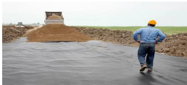
Fig. 12: Geotextil puesta en obra
