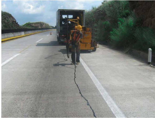
Fig. 8: Sellado de juntas
