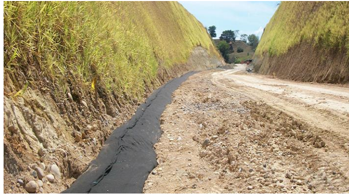
Fig. 16: Geocompuesto puesta en obra
