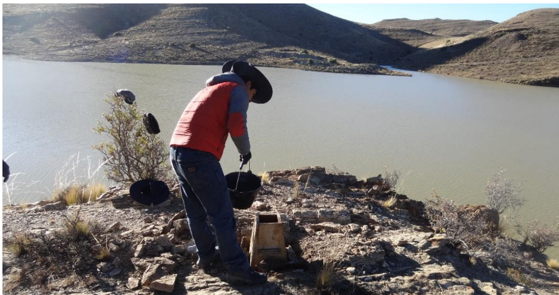
Figura 3. 4 Monumentación de pares geodésicos embalse “El Tranque”
