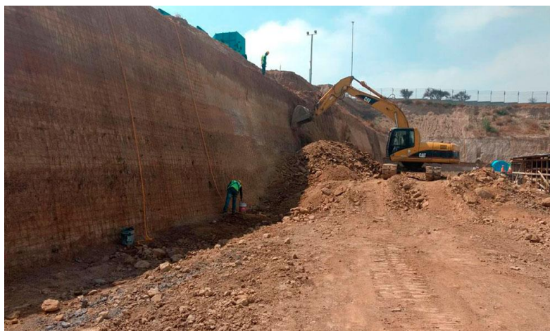
Figura Nro. 63 Movimiento de tierras en taludes
