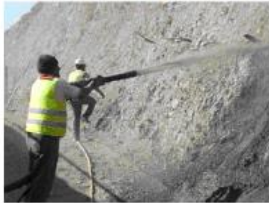
Figura Nro. 24 Aplicación de hormigón lanzado
