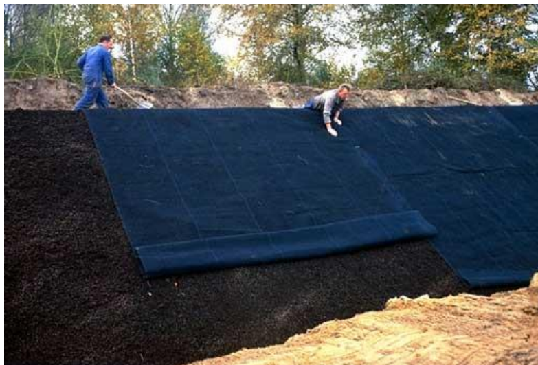
Figura Nro. 70 Malla geo manta antierosiva reforzada
