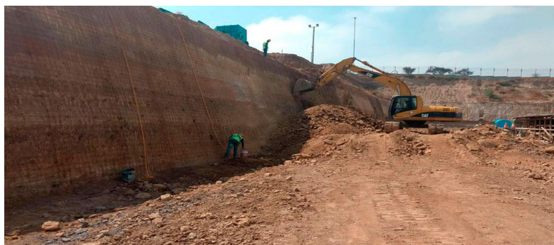
Figura Nro. 66 Talud en corte (reducción de pendiente)
