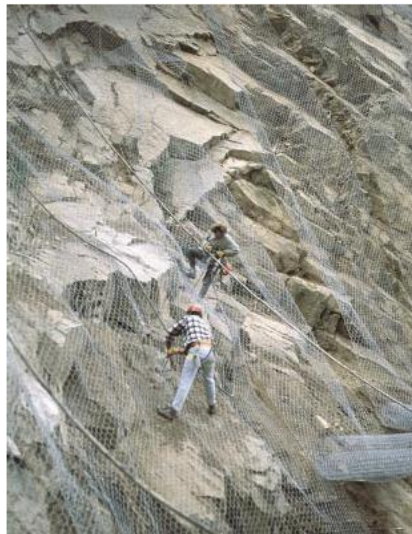
Figura Nro. 17 Estabilización con mallas
