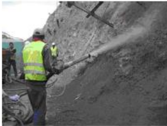
Figura Nro. 23 Limpieza del talud con aire comprimido
