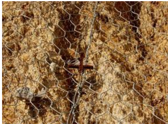
Figura Nro. 19 Colocación de anclas en T.
