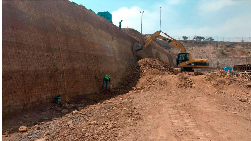
Figura Nro. 67 Reducción de talud para estabilizar
