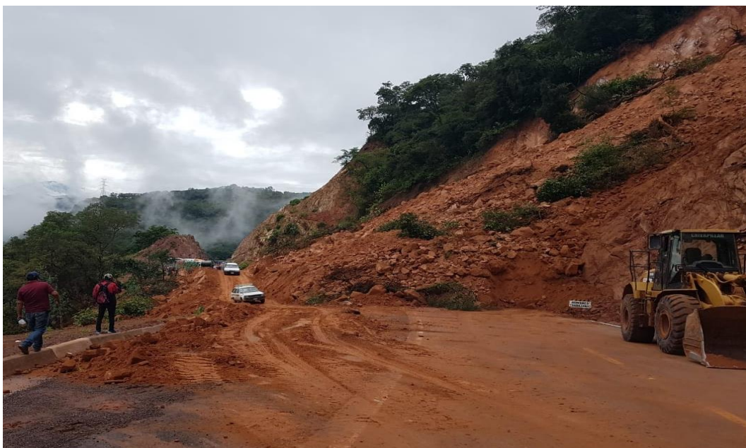
Figura Nro. 1 deslizamientos de talud en el tramo entre ríos palos blancos.
