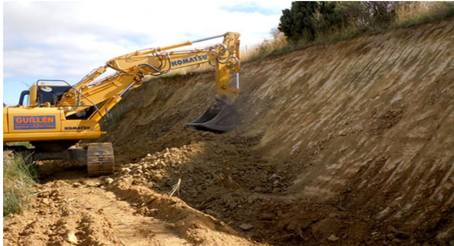
Fuente: Taludes en autopistas noviembre 2013
