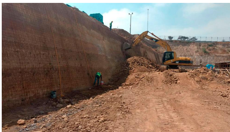
Figura Nro. 64 Movimiento de tierras en taludes
