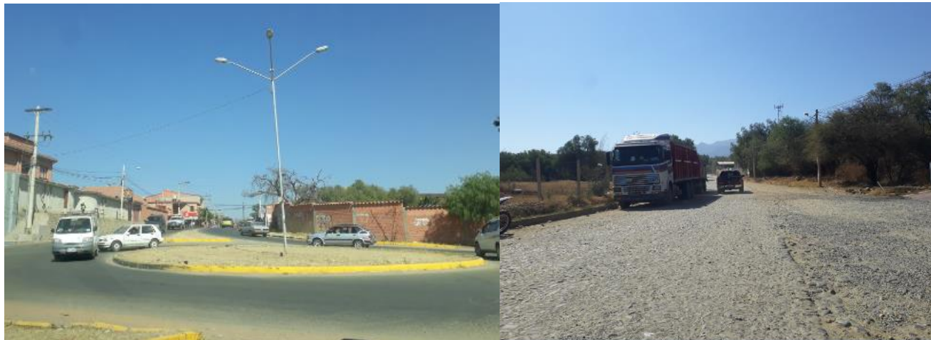
Figura 3.37. Vistas de los accesos a la intersección – punto de estudio 17
