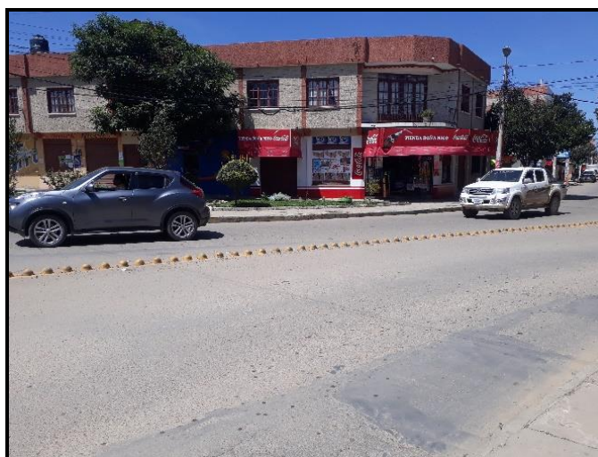
Figura 2.16. Tachones ubicados en la intersección de la Av. Circunvalación y Av. Font, controlando movimientos vehiculares.
