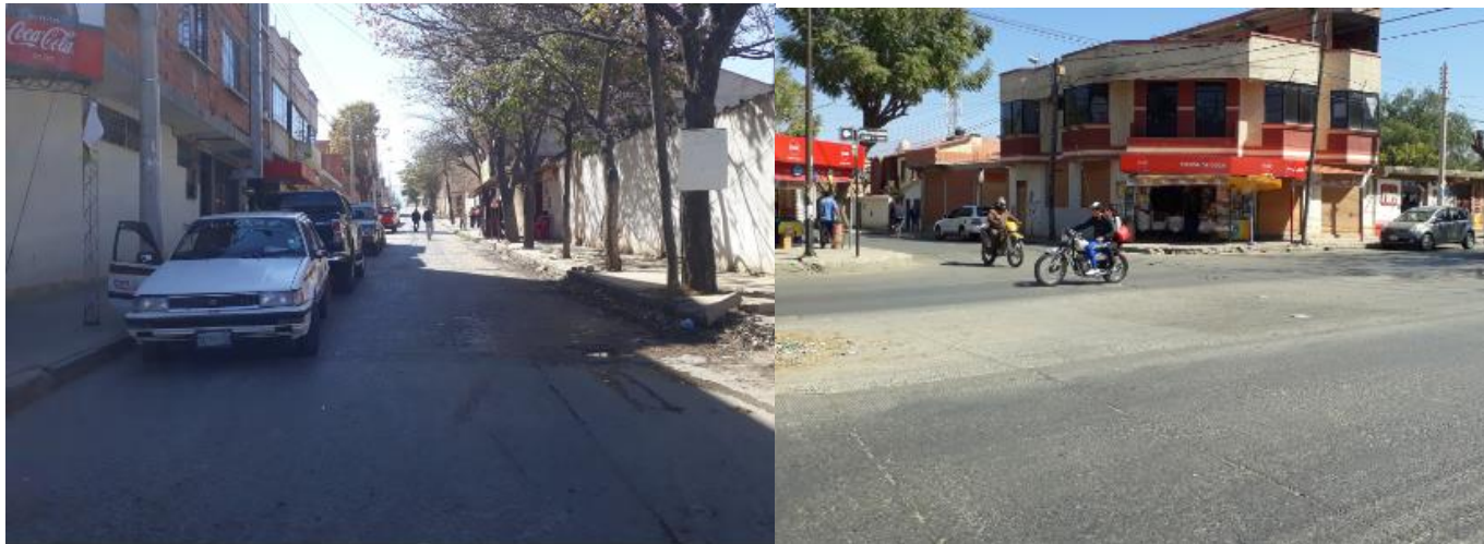
Figura 3.34. Vistas de los accesos a la intersección – punto de estudio 14
