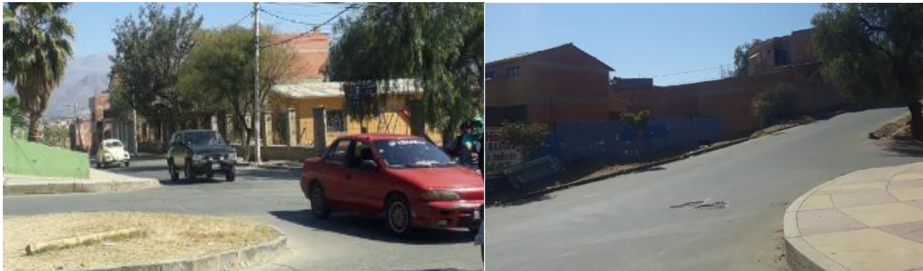
Figura 3.28. Vistas de los accesos a la intersección – punto de estudio 8
