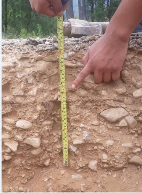
Gráfico 85 Capas estructurales de la vía
