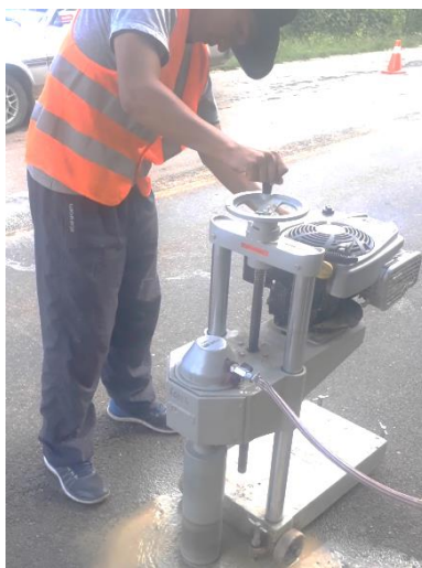
Gráfico 89 Extracción de núcleo del pavimento
