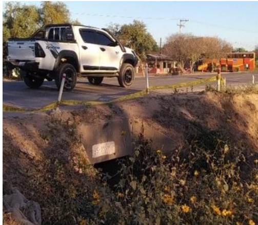
Ilustración 41: Alcantarilla tipo circulares simple y doble
