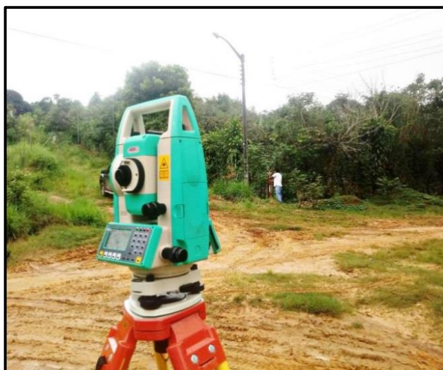
Figura 13: Levantamiento con la estación total en una intersección.
