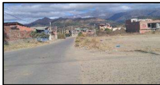
Calle Panamá - Material asfalto
