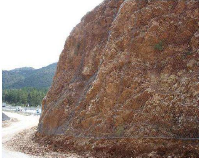
Figura 2.46 Sujeción con cables de acero
