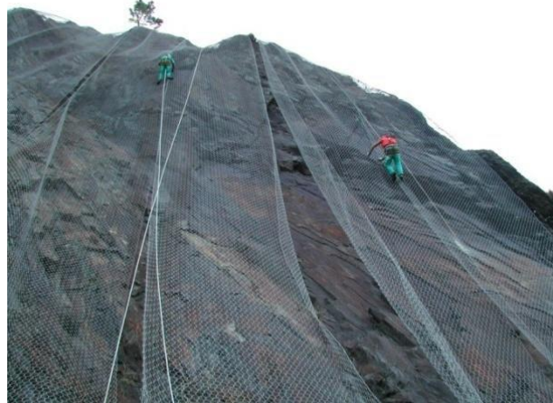
Figura 2.42 Tendido de malla
