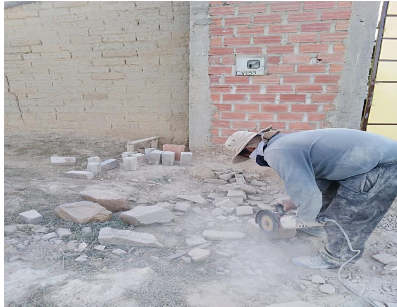
Figura 3.70 Realización del corte de las muestras
