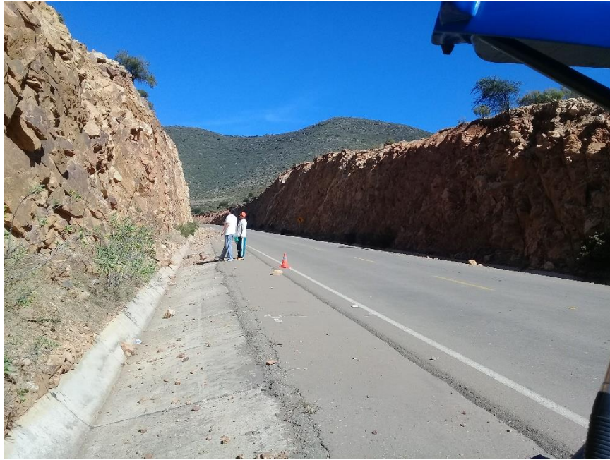
Figura 3.64 Talud ambos lados de la carretera
