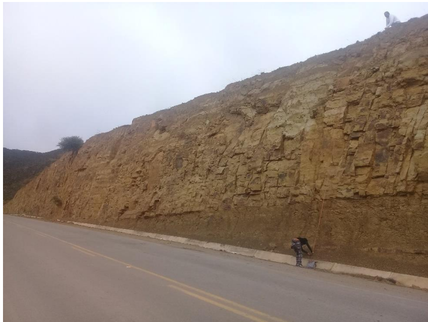
Figura 3. 65 Medición de la altura y longitud del talud a estabilizar
