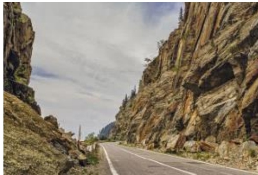
Figura 2.36 Taludes artificiales en roca
