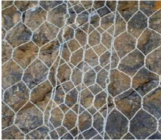
Figura 2.45 Unión con solape
