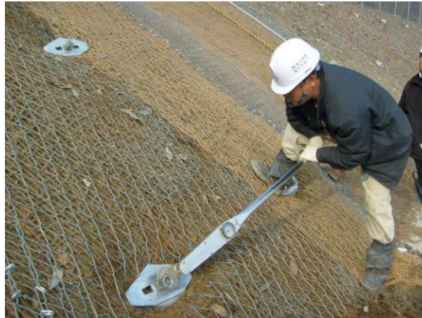
Figura 2.56 Apretado de la tuerca usando llave dinamométrica
