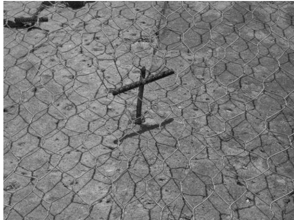
Figura 2.41 Colocación de bulones
