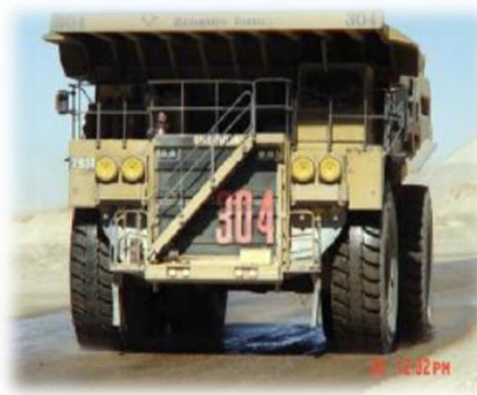
Gráfico N° 19 Compactado del camino estabilizado
