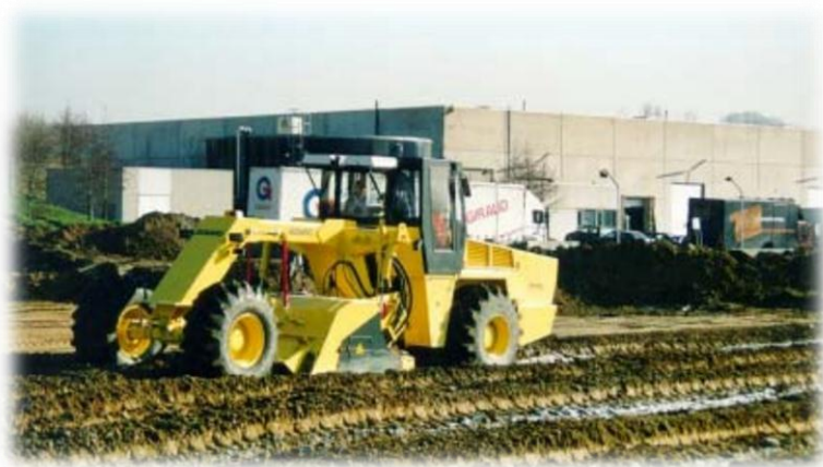
Gráfico N° 12 Escarificación del camino a ser estabilizado
