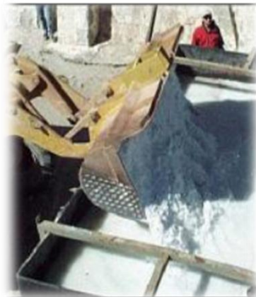
Gráfico N° 6-7 Mezclado de la Bischofita con agua
