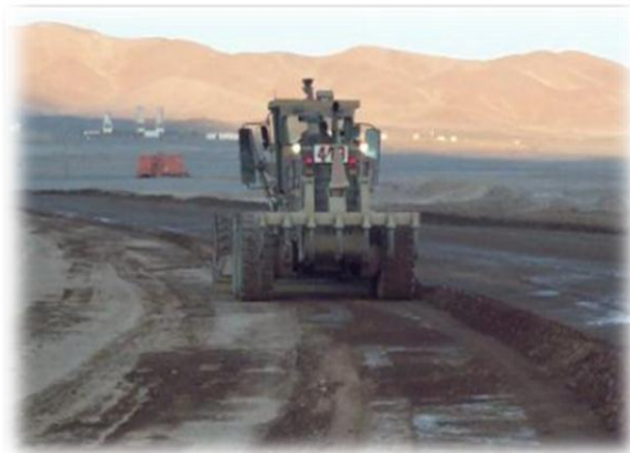
Gráfico N° 8 Preparación del camino para posterior riego
