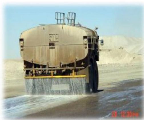
Gráfico N° 9-10 Riego de la salmuera y compactado del camino
