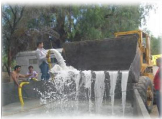
Gráfico N° 13-14-15-16 Proceso de preparación de la solución de Bischofita
