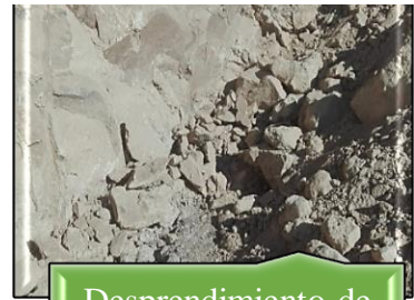
Desprendimiento de terrones in situ
