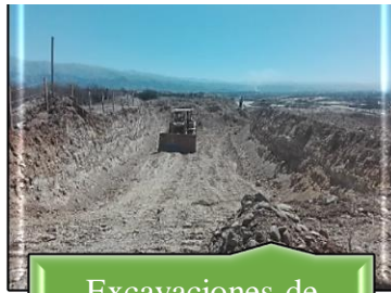
Excavaciones de terreno
