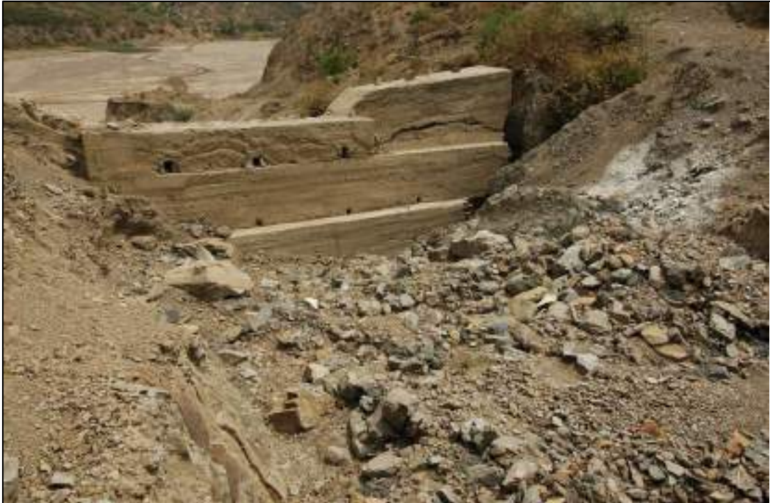
Figura 2.12. Pequeñas obras de control Rio Erque Cochabamba-Bolivia.
