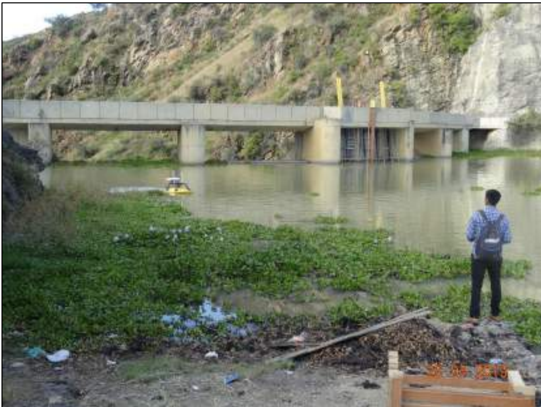
Fotografía 4.7. Levantamiento batimétrico del sector del cuerpo de la presa.
