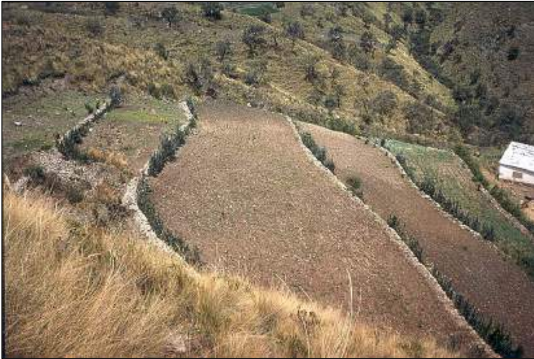
Figura 2.10. Muros para formación de terrazas.
