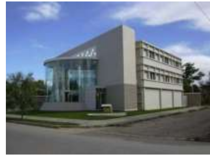
Ilustración 15 Edificio de SOBOCE.
