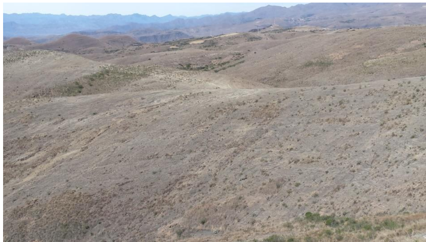
Figura 24. Tierra erosionada con escasa vegetación. (Elaboración propia)
