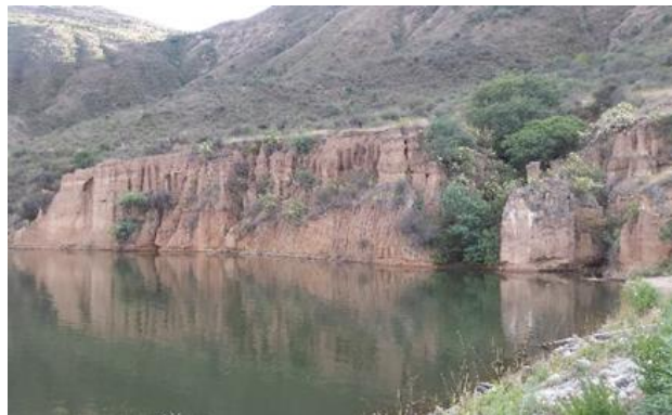
Figura 3. Erosión en el estribo izquierdo de la presa. (Autoría propia)
