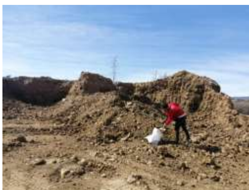
Imagen 3.3:1 Acopio de los bancos de materiales para la capa sub base y base
