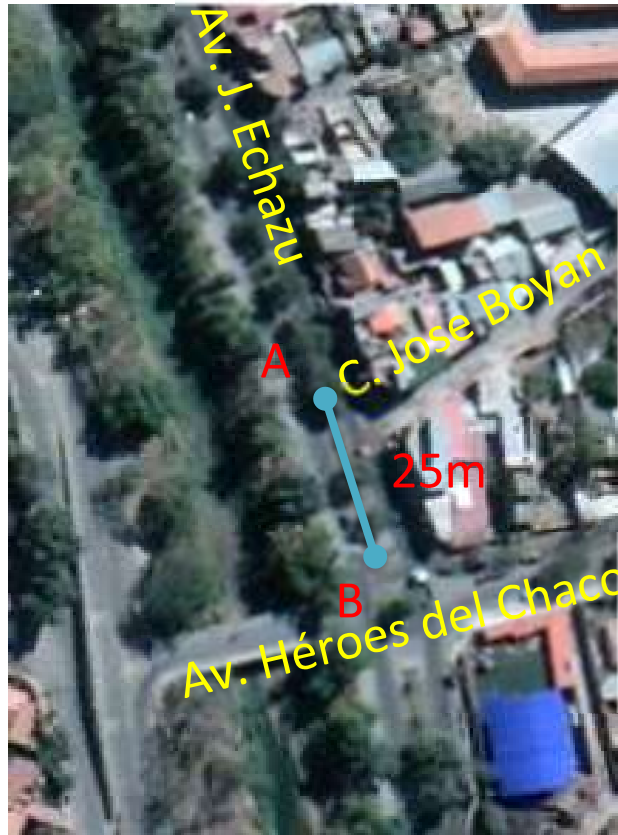
Imagen 13. Tramo Avda J. Echazú entre Calle José Boyan-Avda Héroes del Chaco
