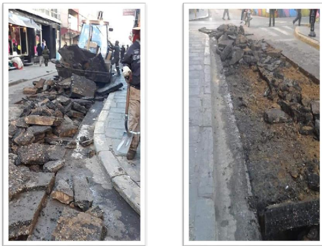
Figura 3.14. Carpeta asfáltica removida por el GAMT para bacheo de calle.
