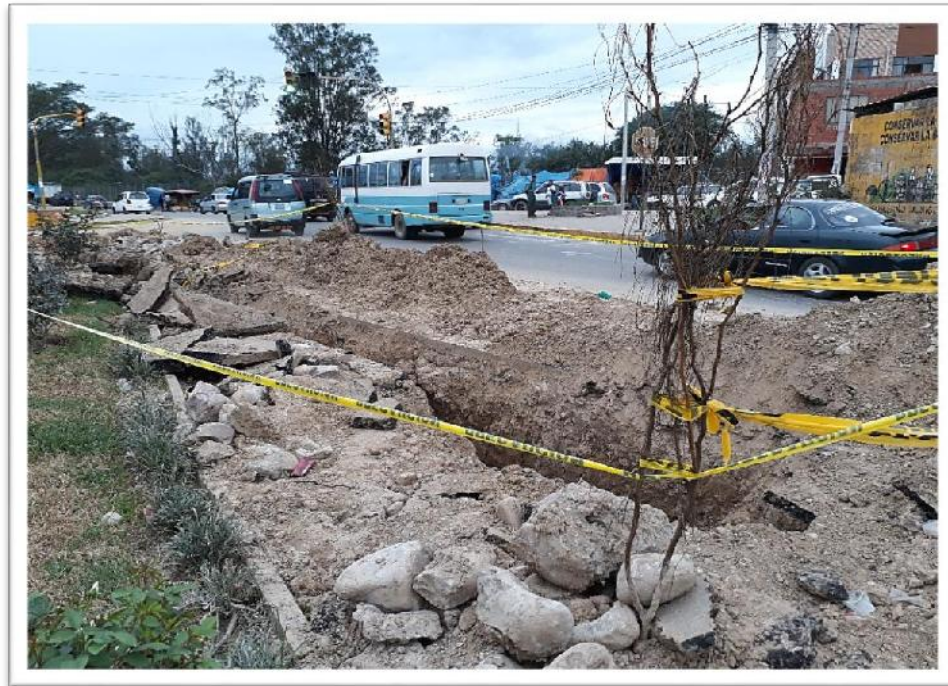
Figura 3.11. Avenida Panamericana. Carpeta asfáltica retirada para trabajos de COSAALT.
