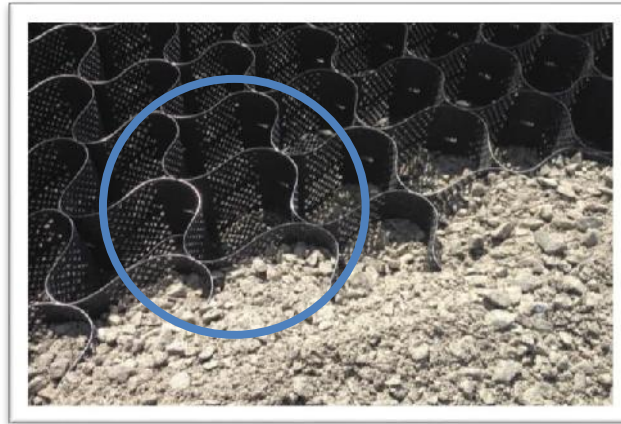
Figura 2.13. Estructura típica de geoceldas.
