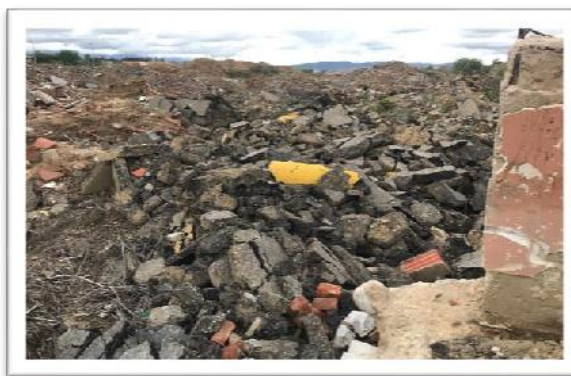
Figura 3.15. Capa de pavimento depositado como desecho.
