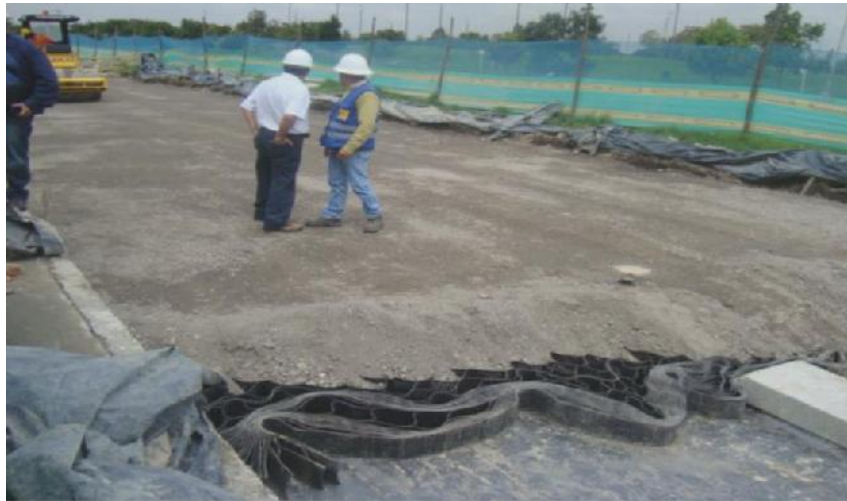
Figura 2.22. Aplicación sistema de geoceldas.
