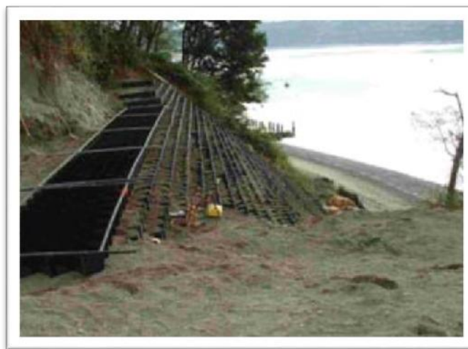
Figura 2.20. Muros de contención de tierras.
