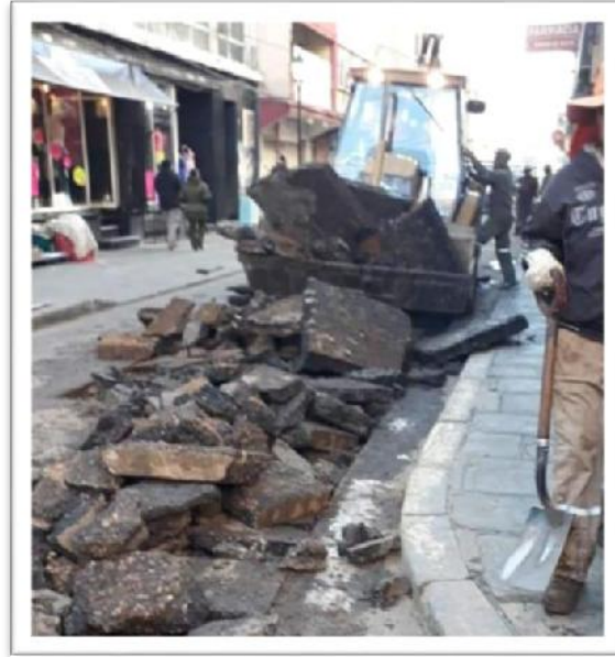
Figura 3.10. Pala cargadora en la remoción de capa asfáltica
