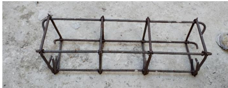
Figura 46 Armadura de acero corrugado.
