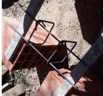
Figura 45 Ensamblado de armadura:
