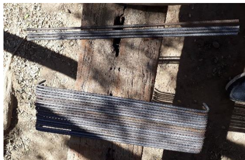
Figura 44 Doblado de armadura longitudinal
