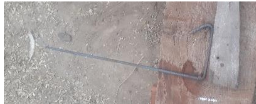
Figura 42 Doblado de estribos
