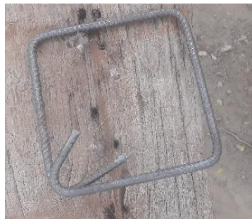
Figura 43 Estribo terminado
