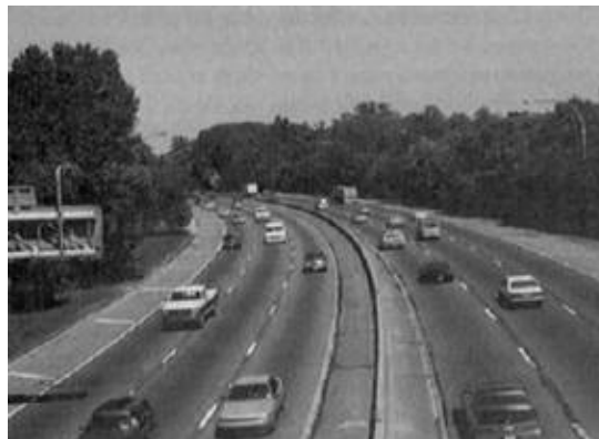
Figura 2.10 Nivel de servicio C
