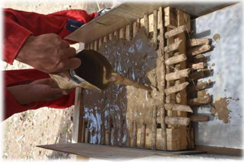
*Figura 88 aplicación de morteros fluido*
