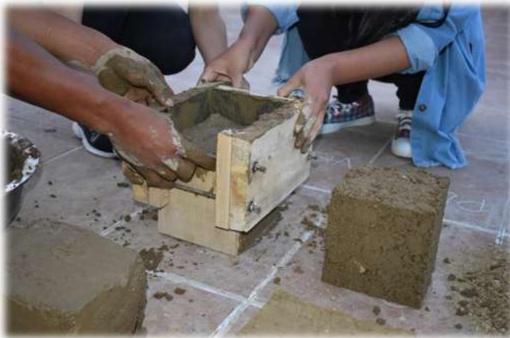
*Figura 33. Se el reconocimiento de los estados hídricos de la tierra (seco, húmedo, plástico y líquido) para los distintos usos en la construcción.*
