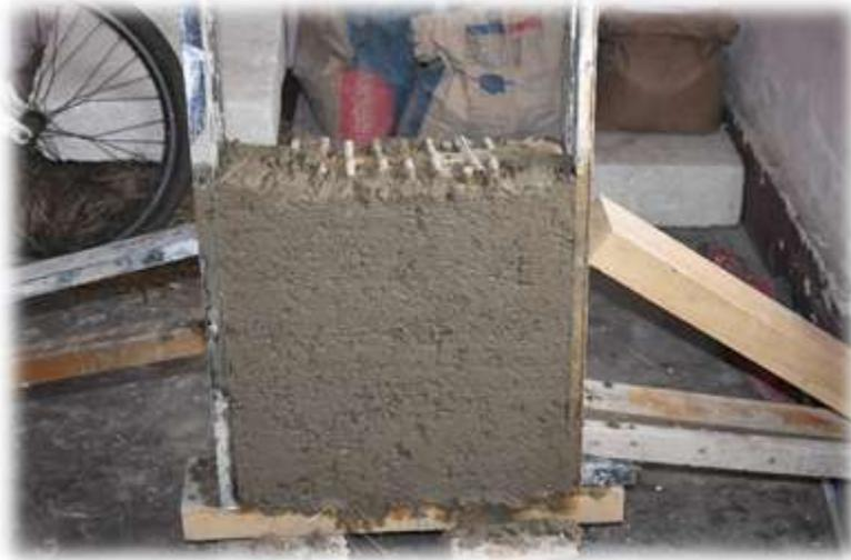
*Figura 96-97 revestimiento con cemento*
