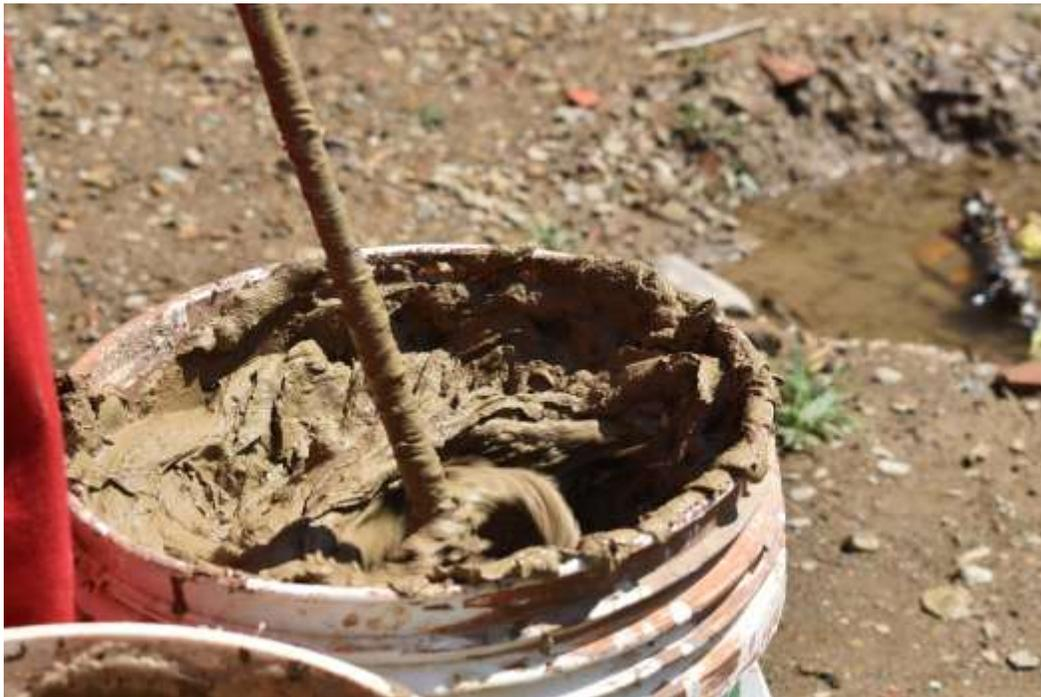
*Figura 86 Preparación mortero fluido para primera capa*
