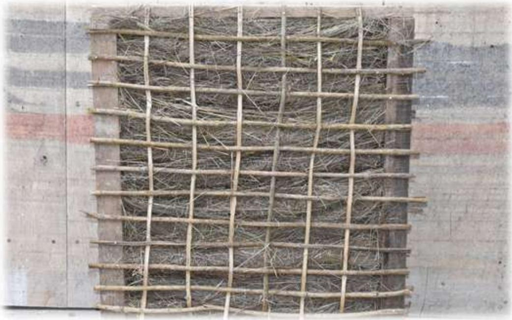
*Figura 81-82 Entramados con relleno de paja*
