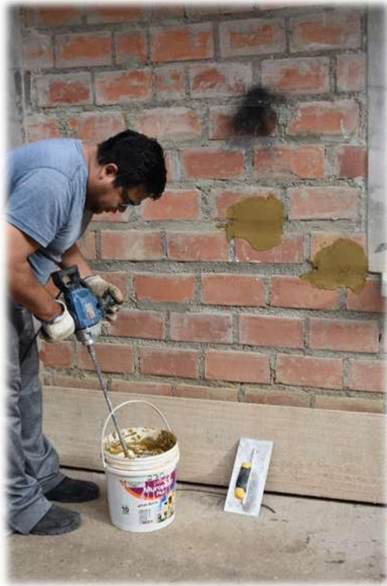
*Figura 87 Preparación y prueba de mortero de barro*
