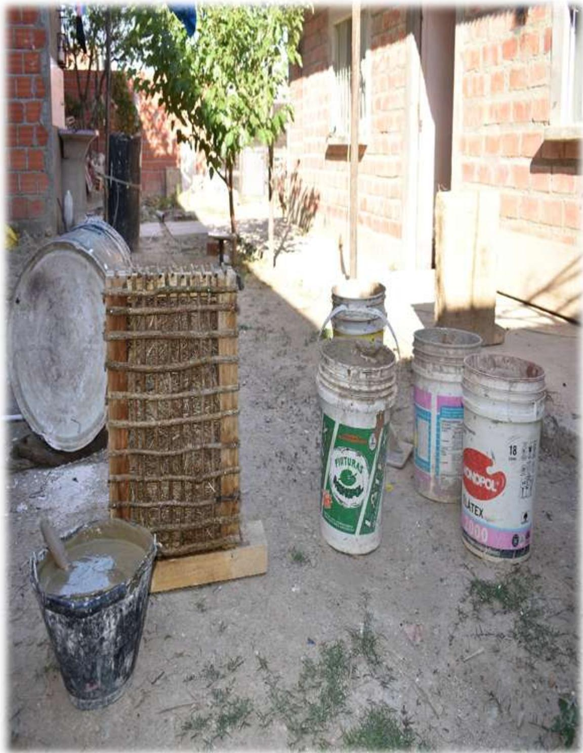
*Figura 83 Entramados con relleno de paja antes del revestimiento*
