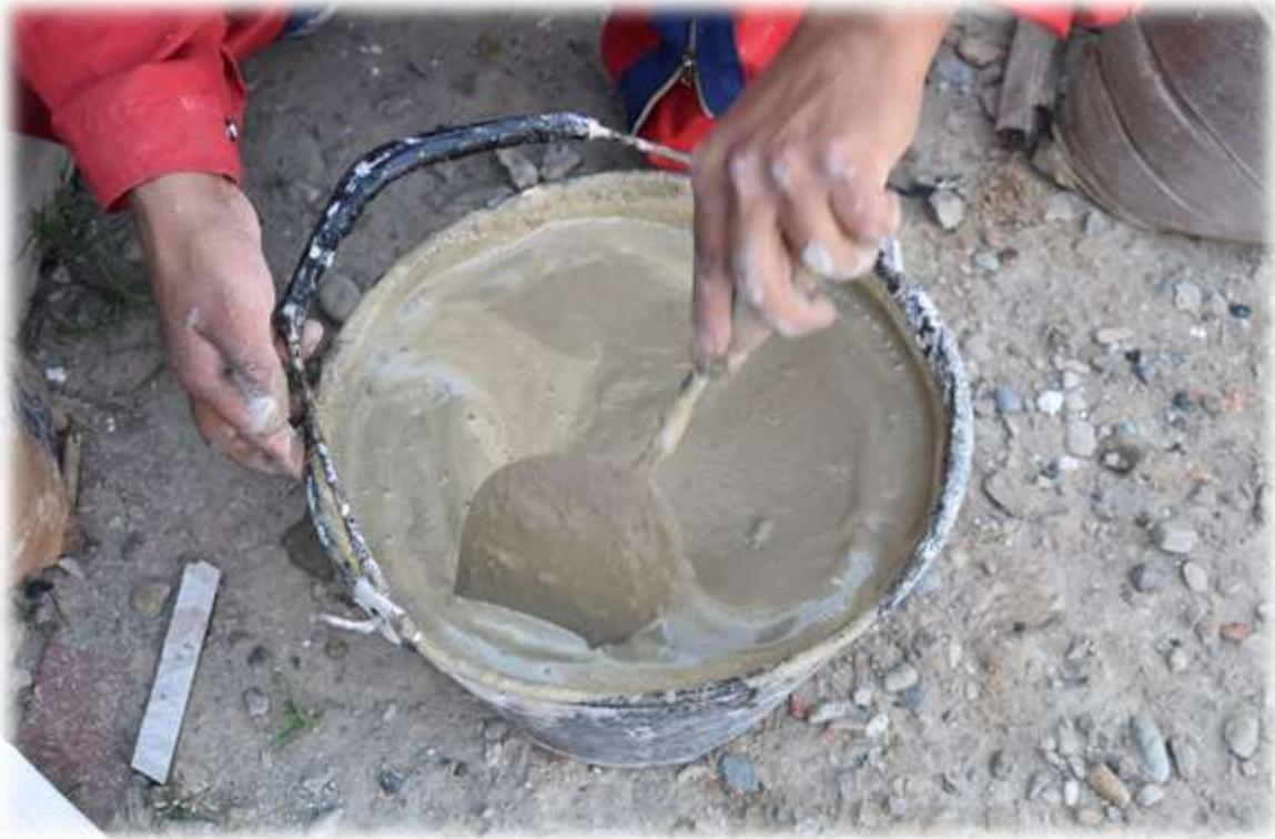
*Figura 85 Preparación mortero fluido para primera capa*
