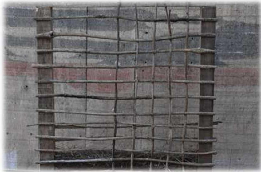
*Figura 78 Entramado de bejucos con bastidor de listones del lugar*
