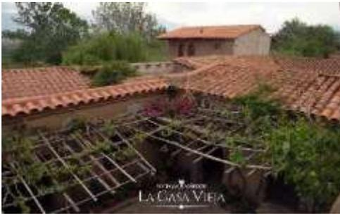
Cubierta de teja colonial que descansa sobre una estructura de cerchas, vigas y tijerales de madera, muros de adobe con revoque interno de arena y cal, arena o solo yeso.
