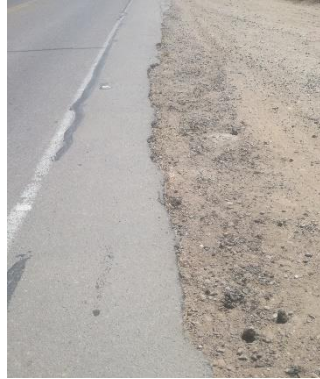
Figura 4. 11. Áreas para realizar sellado de grietas de borde, longitudinales y transversales.
