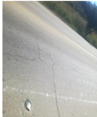
Figura 4. 11. Áreas para realizar sellado de grietas de borde, longitudinales y transversales.
