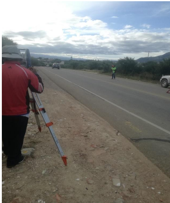
Figura 3. 8. Levantamiento de datos del perfil de rodadura.
