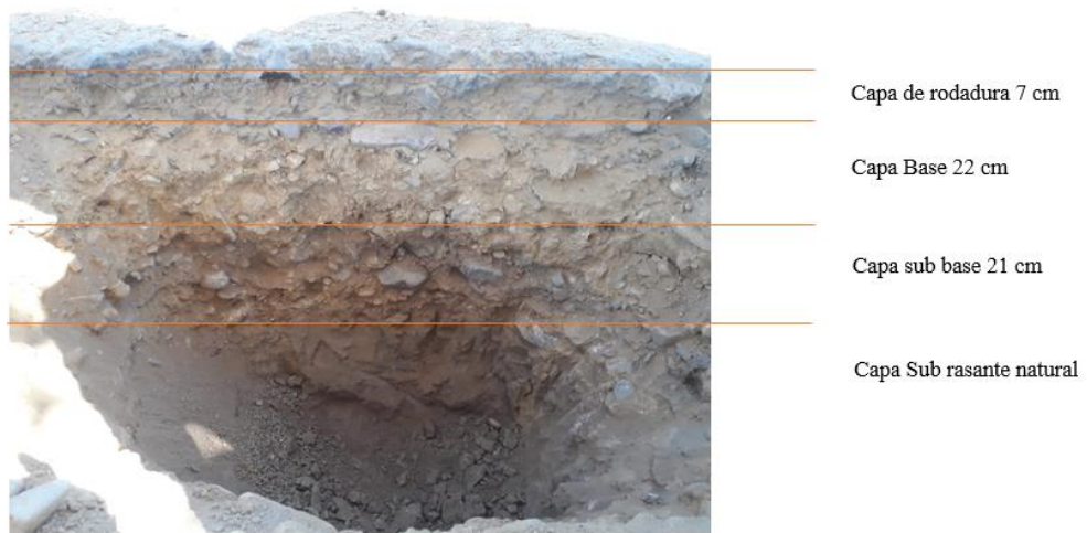
Figura 3. 6. Extracción de calicata progresiva 2+500 y espesores de la capa base, subbase y rasante natural.
