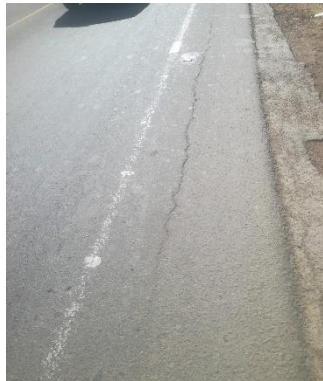
Figura 4. 11. Áreas para realizar sellado de grietas de borde, longitudinales y transversales.
