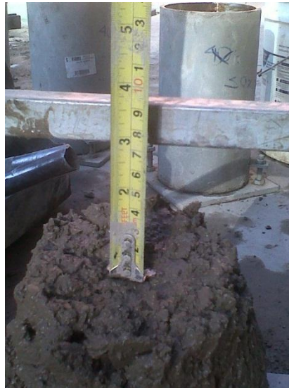
Figura 3.4 Asentamiento de la mezcla de hormigón
