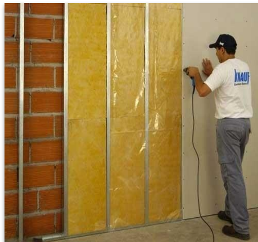
Figura Nº 4.2 Aislamiento de paredes
