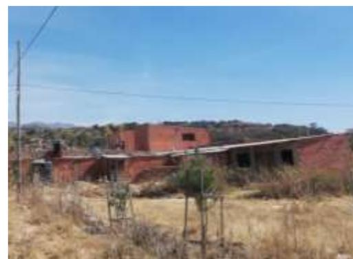
Viviendas con muro de ladrillo y chapa en cubierta
