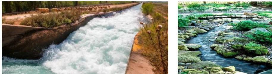
Imágenes referenciales de acequias.
