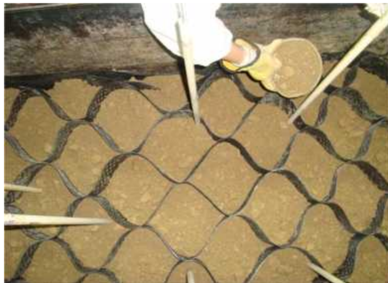
Fotografía 0.9 Geoceldas con material de relleno
