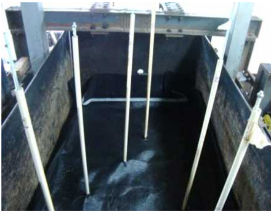
Fotografía 0.7 Geotextil en la interfase
