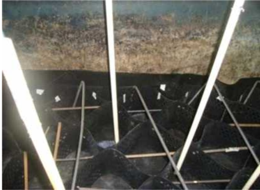
Fotografía 0.8 Montajes de las geoceldas
