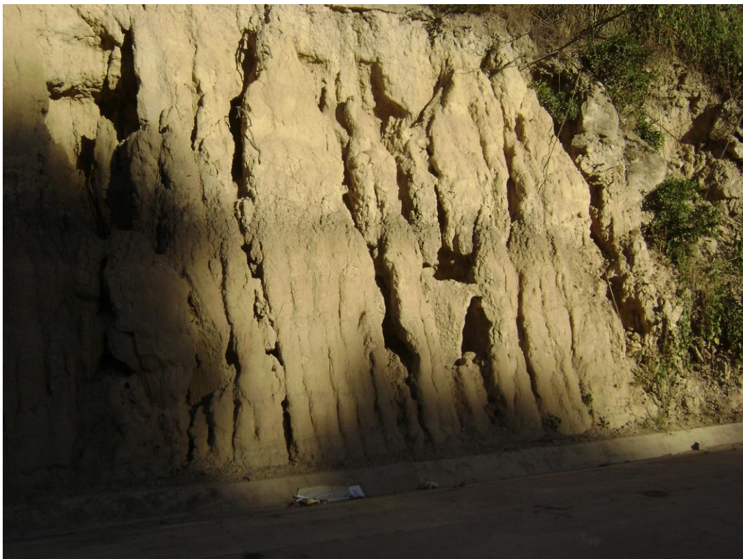
Degradación por erosión
