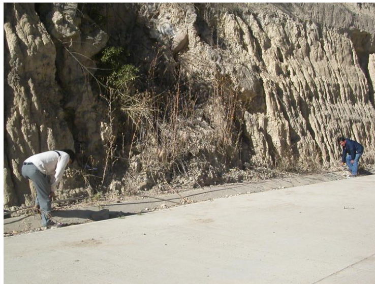
Medición de la Longitud del Talud
