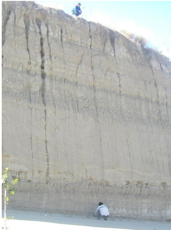
Medición de la Altura del Talud
