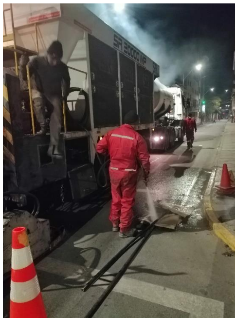
Figura 4.1. Maquinaria y equipo durante el tendido de micropavimento.
