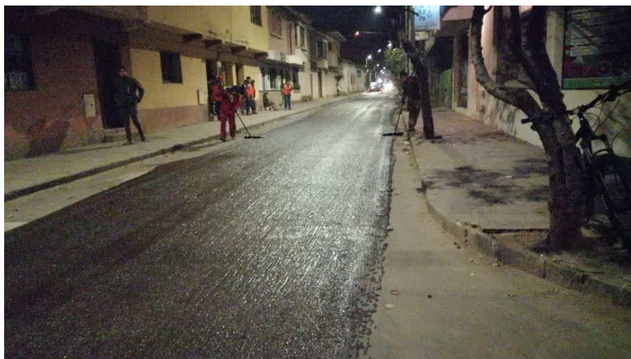
Figura 4.2. Acabado final del micropavimento.
