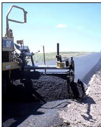
Figura 2.3. Colocación de micropavimento
