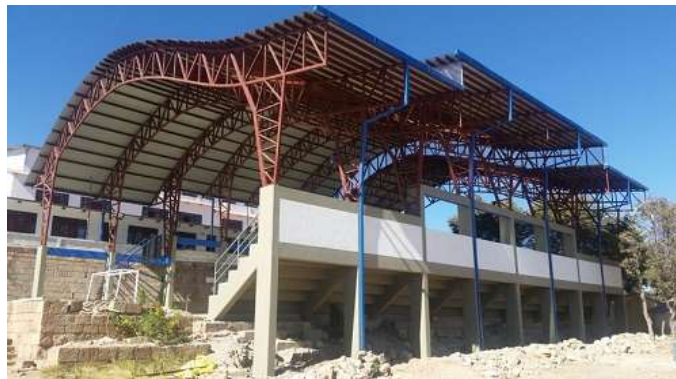
Figura 4. 1 Construcciones de tinglados parabólicos en Bolivia.
