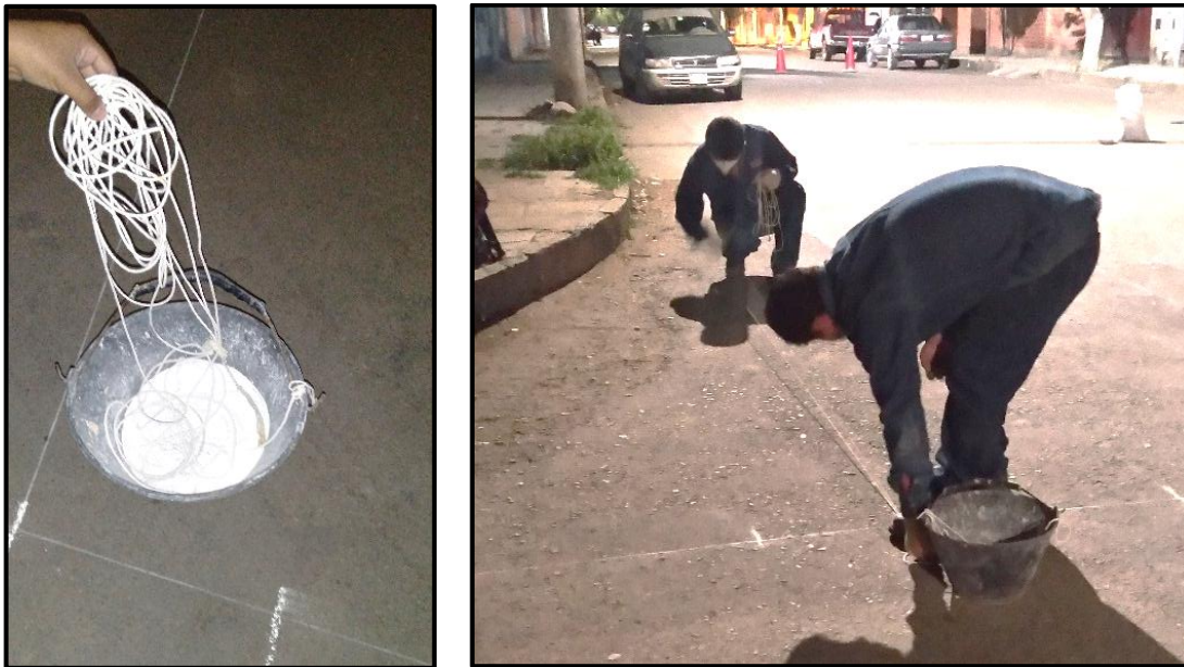
Figura 55. Materiales y marcado de paso peatonal
