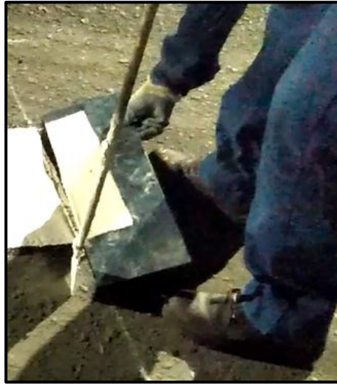
Figura 70. Extracción de muestras para el control de espesores
