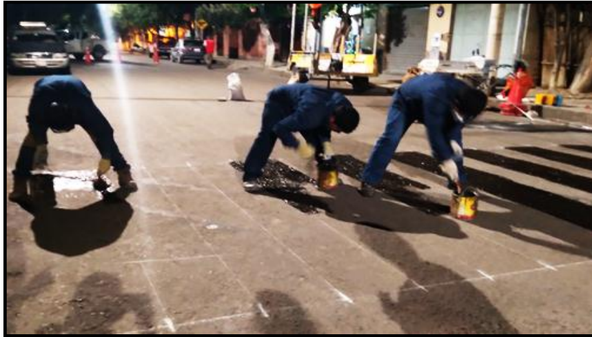
Figura 56. Aplicación del imprimante Primex
