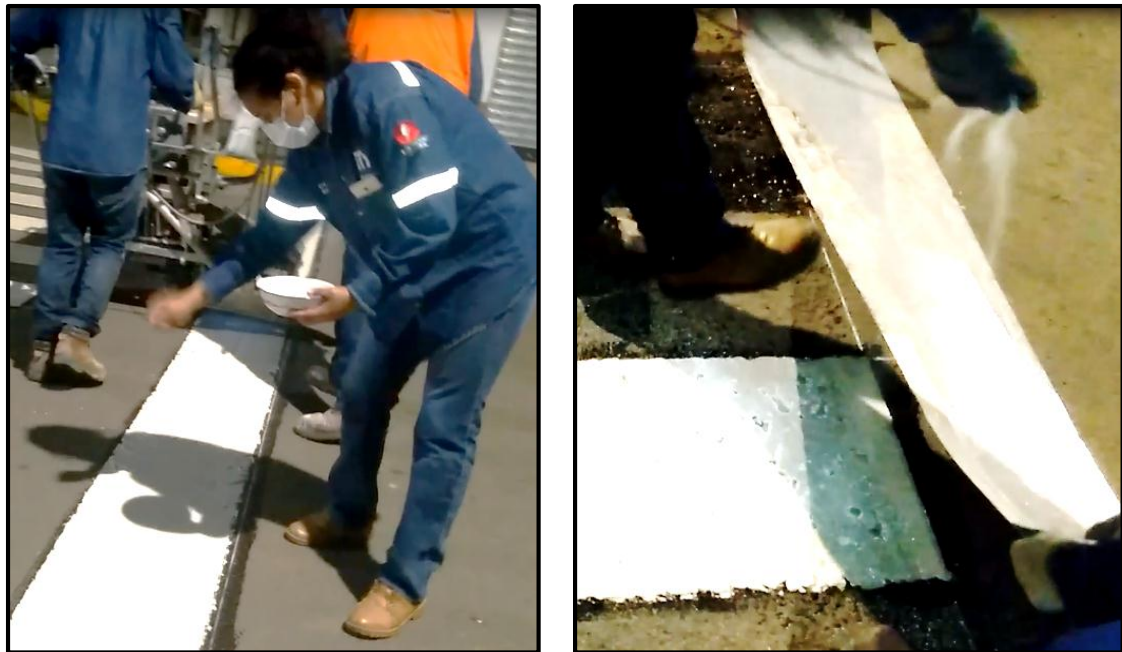
Figura 66. Sembrado de microesferas de vidrio sobre la marca de la cebra
