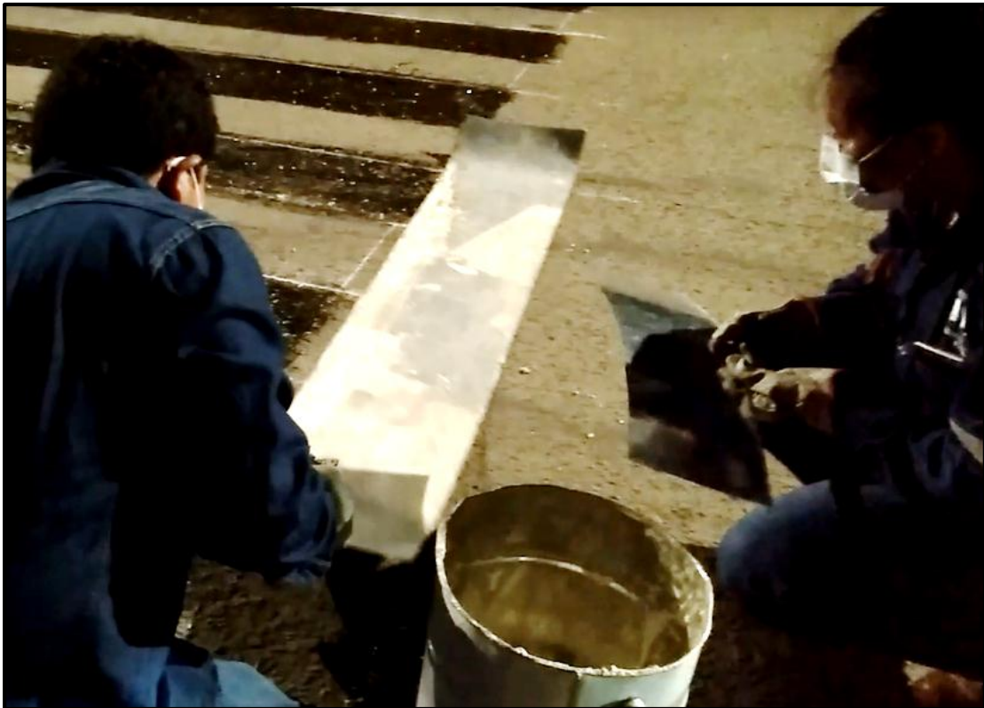
Figura 62. Calibración del espeso de la pintura en campo
