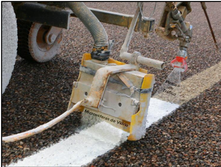
Figura 11 Aplicación por pulverización
