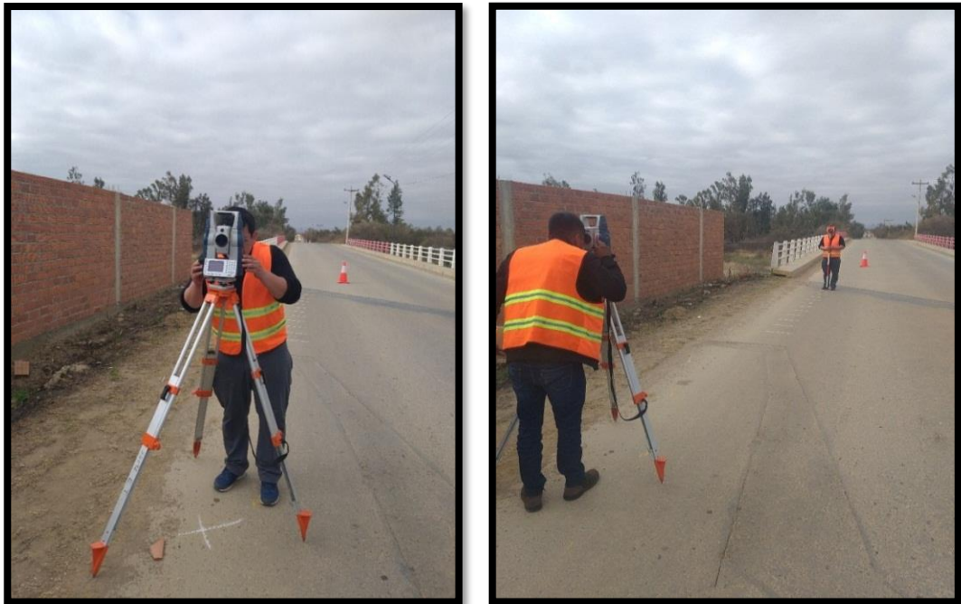
Figura N° 30: Calibración del equipo topográfico y determinación de los puntos más relevantes.
