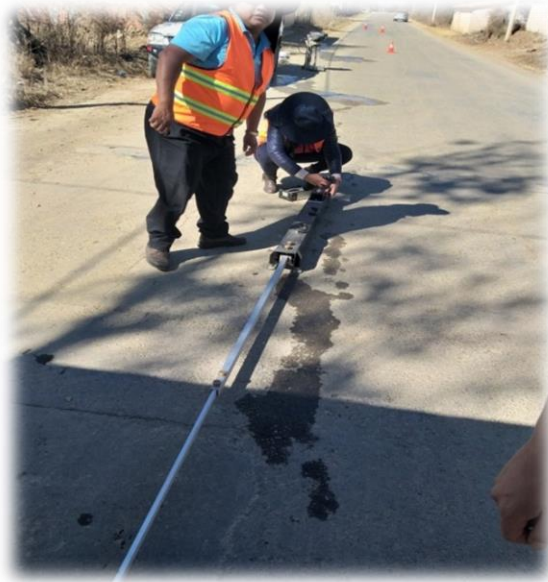
Figura N° 46: Ajuste de la viga Benkelman km 07 + 800
