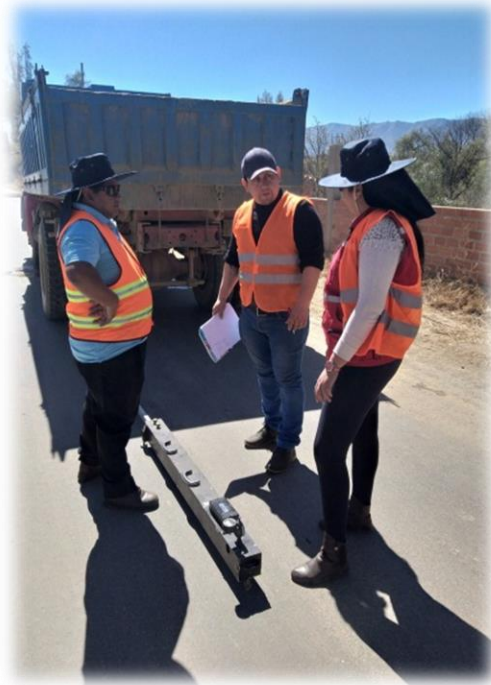
Figura N° 45: Lectura de dial de la viga Benkelman
