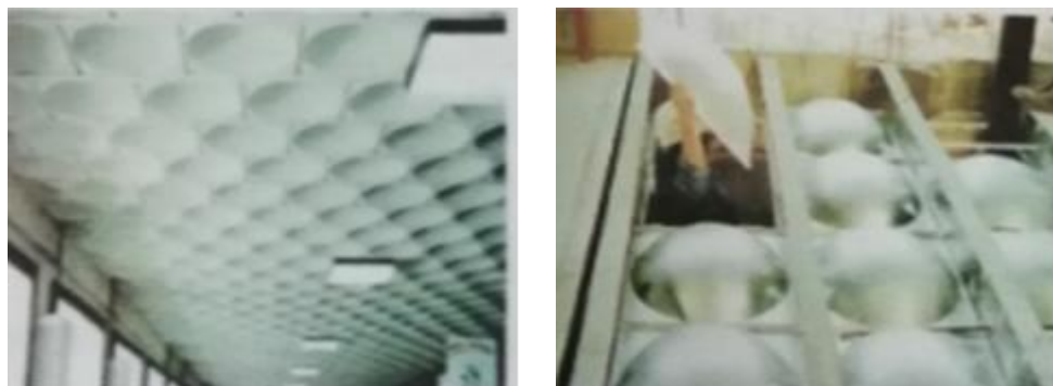
Figura 4.4. Aspectos de los forjados de casetones especiales.
