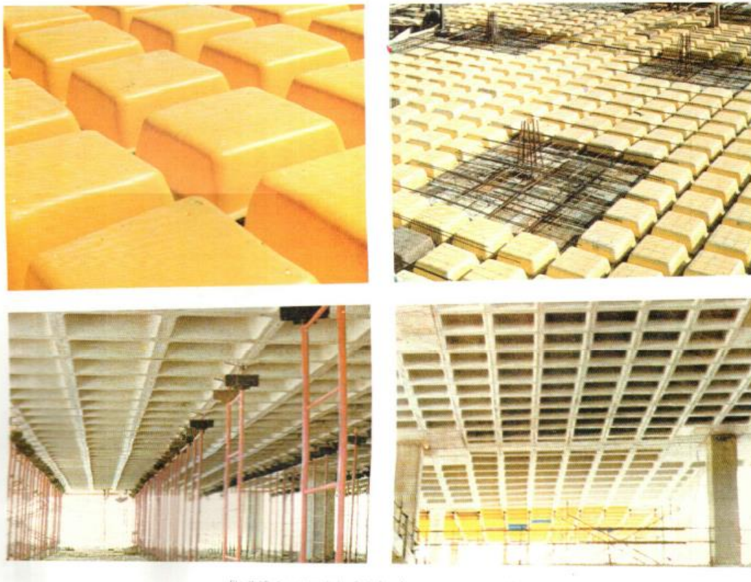
Figura 4.3. Aspectos de los forjados de casetones recuperables
