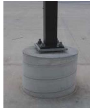
Figura 2.17: Terminación fabricada in situ
