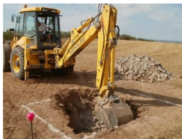
Figura 4.6: Excavado de zapatas con maquinaria Fuente: Arqhy's Decoración
