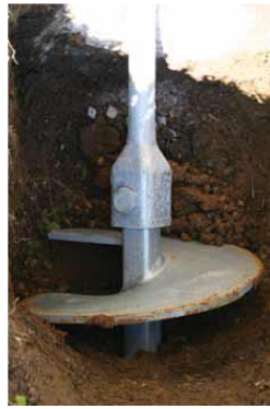
Figura 2.15: Hélice y fuste de pilote helicoidal Fuente: Manual de diseño técnico de AB Chance
