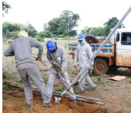
Figura 4.4: Instalación de pilotes helicoidales inclinados para torre eléctrica en Brasil
