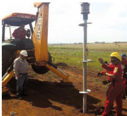
Figura 4.3: Instalación de pilotes helicoidales verticales para torre eléctrica en Brasil
