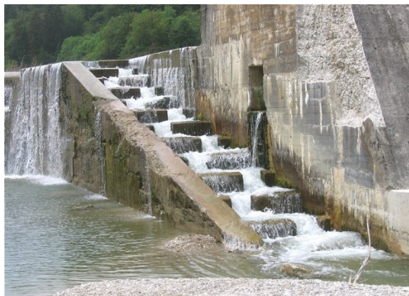
Ilustración 2-3. Escalera de peces, caída escalonada con vertederos
