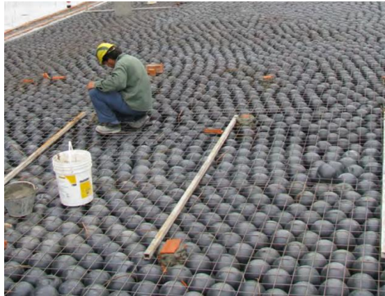
Figura 4. 7 Losa de relleno estructural
