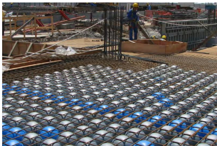
Figura 4. 6 Losas sobre pilotes o bases
