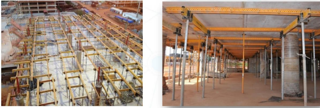
Figura 4. 4 Reducción del apuntalamiento
