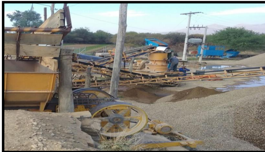
Figura3.2. Chancadora para la provisión de material
