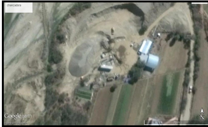
Figura 3.1. Ubicación de la planta de áridos “Garzón”
