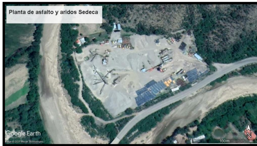
Figura3.3. Chancadora de SEDECA
