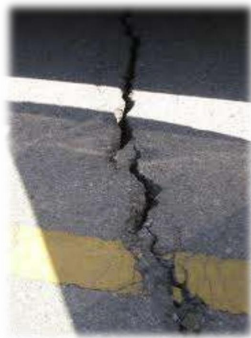
Figura 2.4: Muestra de poca durabilidad de la mezcla asfáltica.
