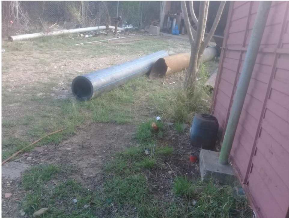
Figura 3.4 Tuberías instaladas en la red
