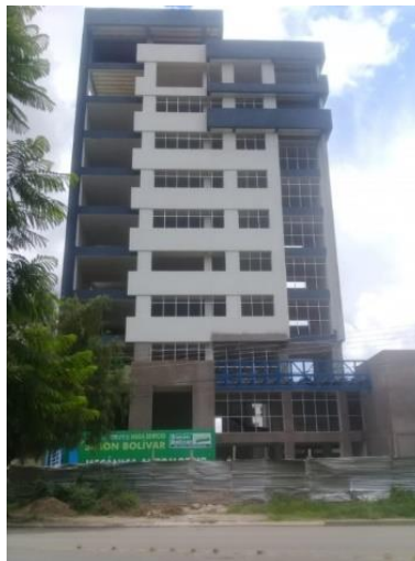
Figura 3.31. Construcción del instituto Tecnológico Simón Bolívar
