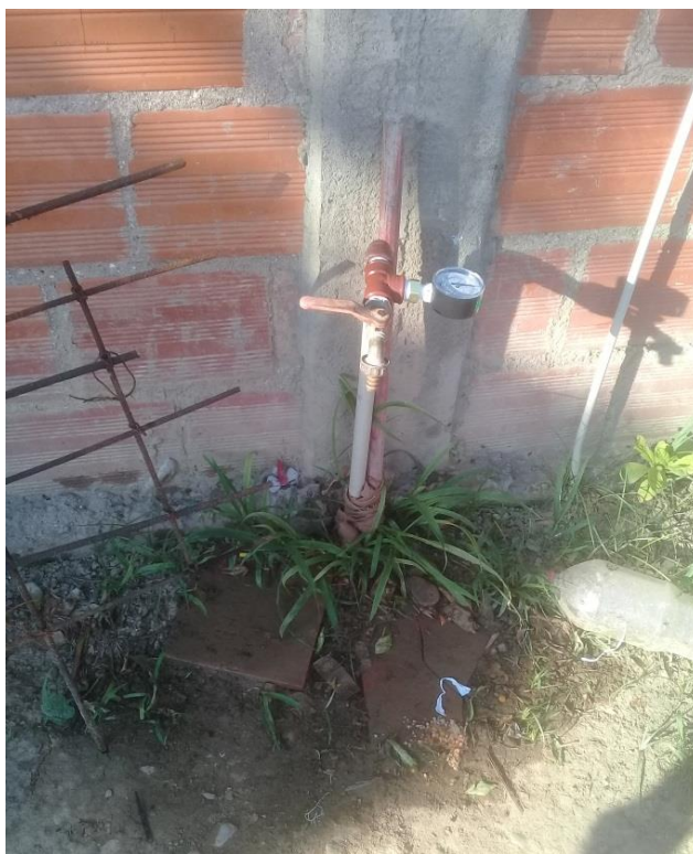
Figura 3.12 Instalación del manómetro en el nudo n1
