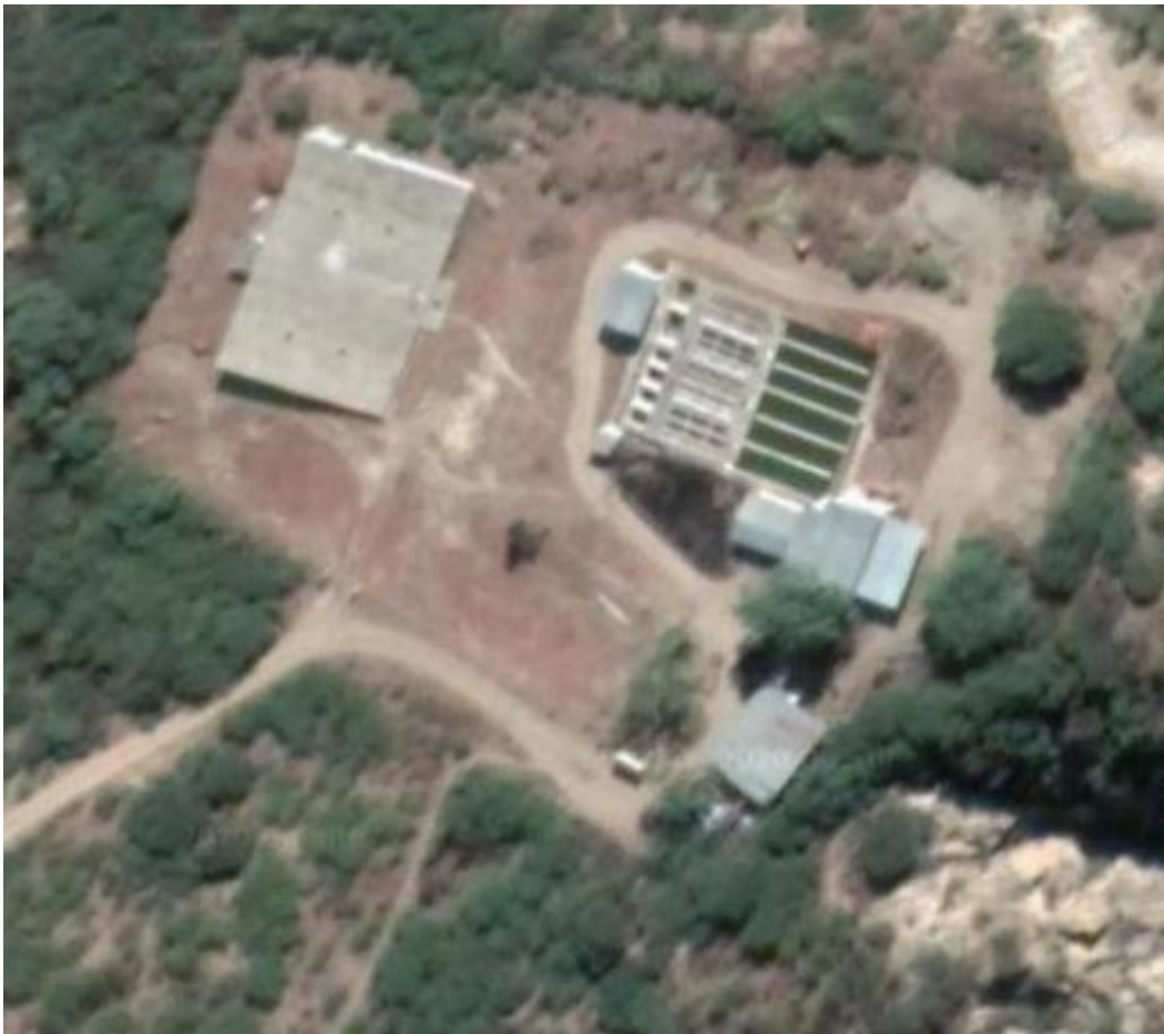
Figura 3.9 Ubicación del tanque de almacenamiento
