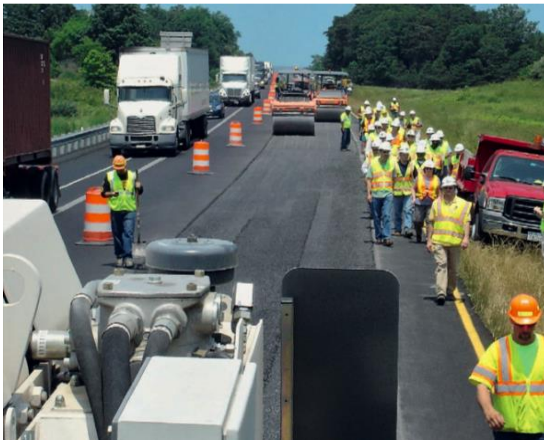
Figura 2.21: Carretera pavimentada haciendo uso del asfalto espumado
