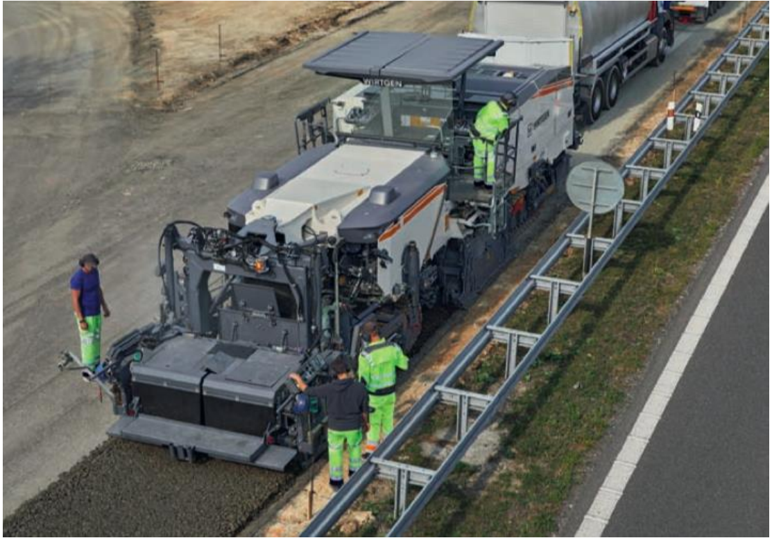
Figura 2.18: Asfaltado in situ con asfalto espumado
