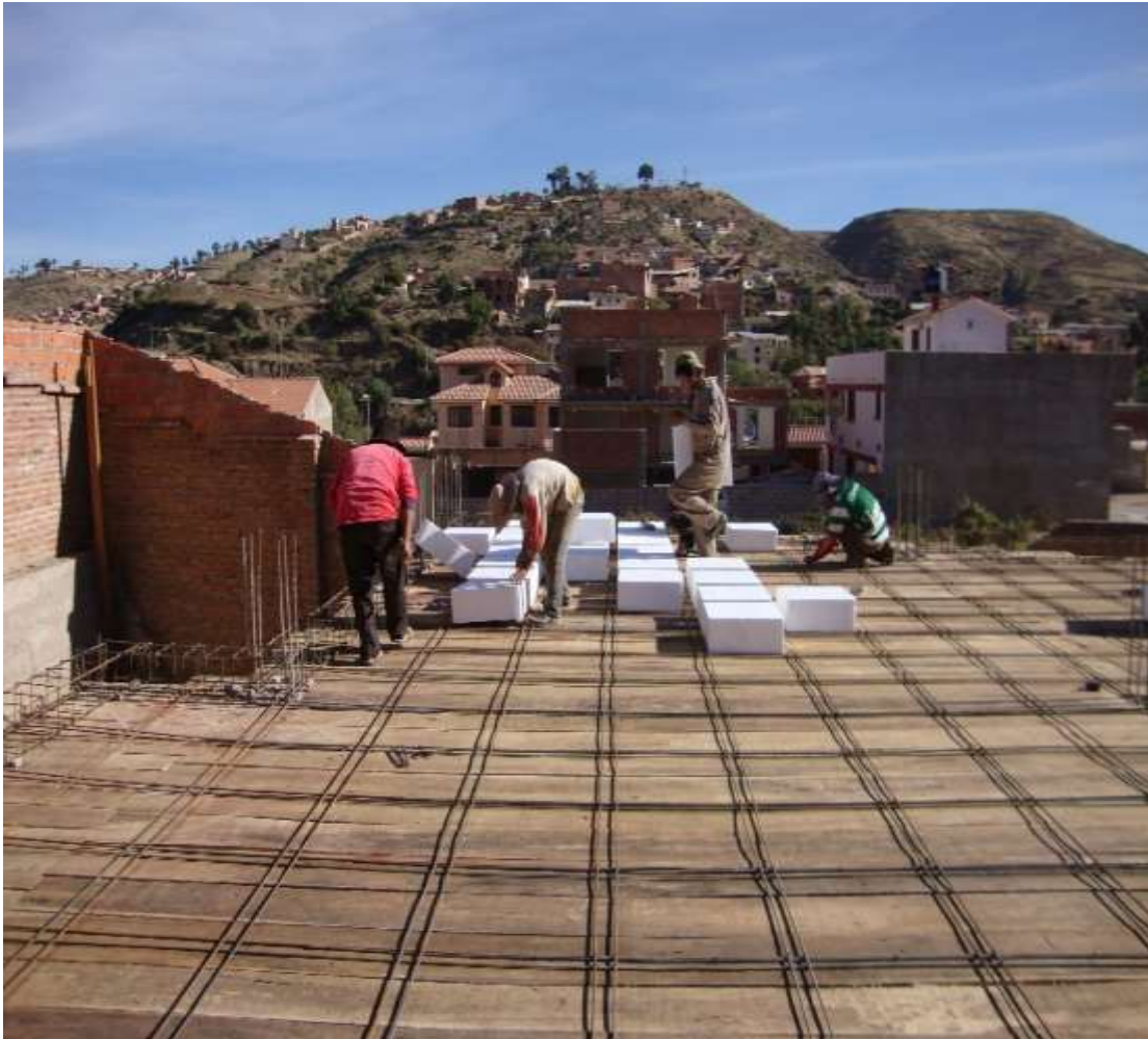
Figura N° 4.43 Forjados Reticulares con Casetones de Aligeramiento Perdido
