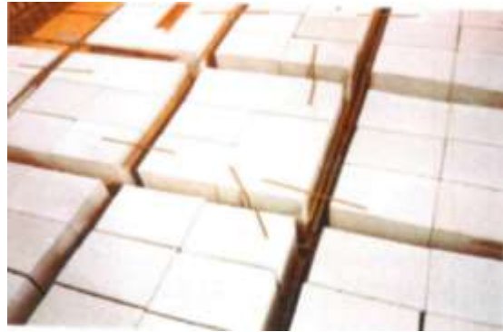
Figura N° 4.1 Forjados Reticulares con Casetones de Aligeramiento Perdido
