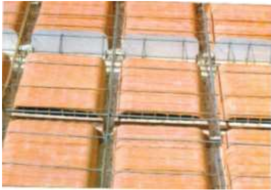
Figura N° 4.1 Forjados Reticulares con Casetones de Aligeramiento Perdido
