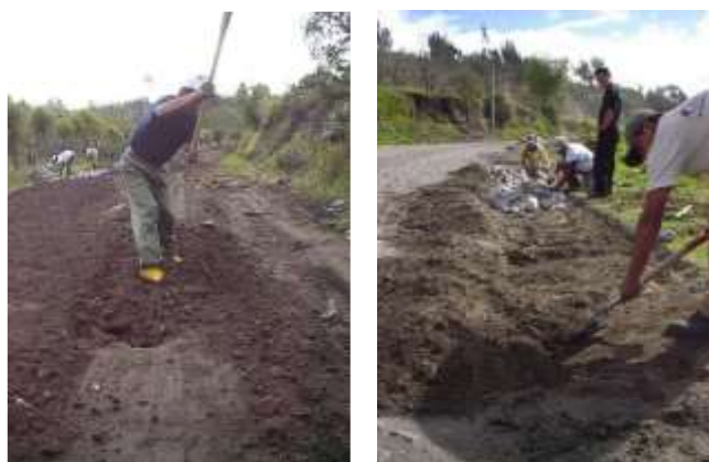
Imagen 2.3:3 Disgregación de Subrasante
