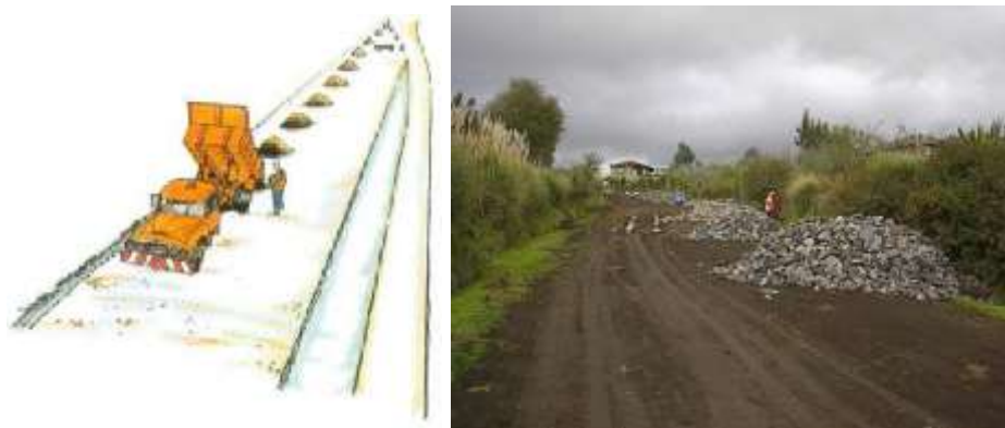
Imagen 2.3:2 Transporte y Acopio de Material en el Proyecto
