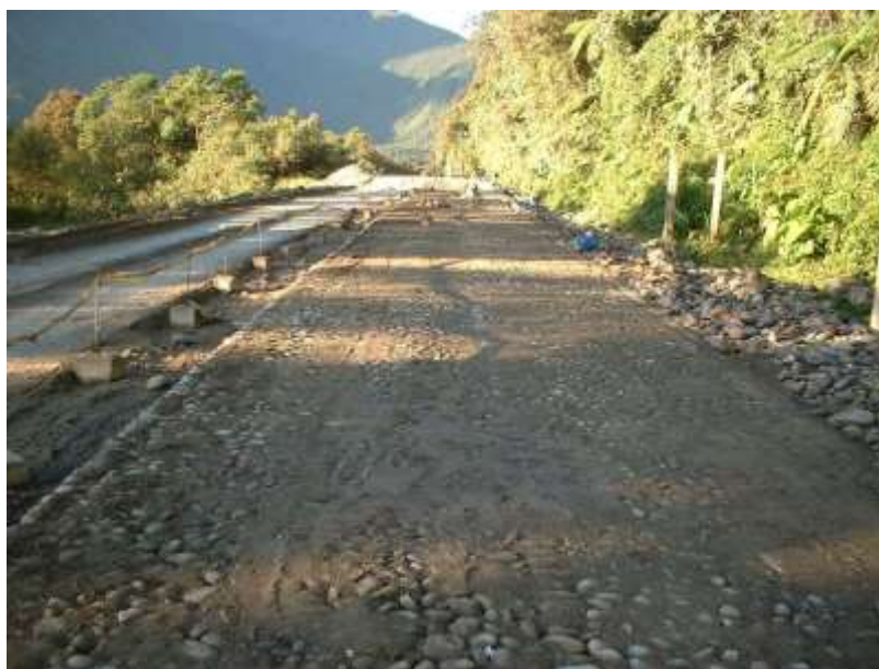
Imagen 2.3:5 Terminado del empedrado
