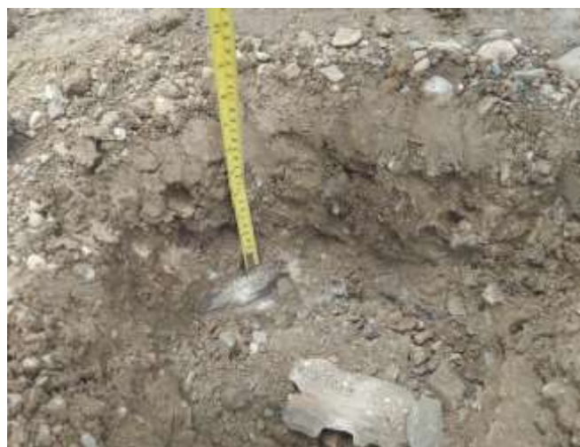
Figura 3.2.2.2 Medición de la capa de rodadura.
