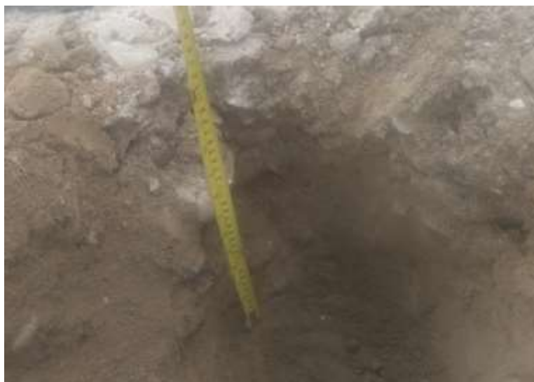
Figura 3.2.3.3 Medición de la capa de rodadura.
