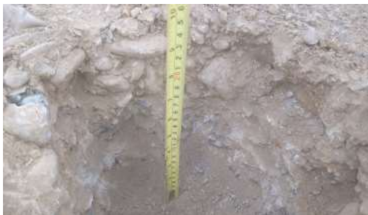
Figura 3.2.1.3 Medición de la capa de rodadura.
