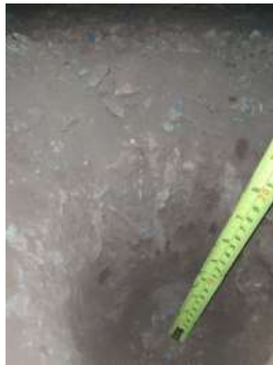
Figura 3.2.4.2 Medición de la capa de rodadura.
