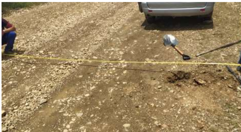
Figura 3.2.2.1 Medición del ancho del tramo.
