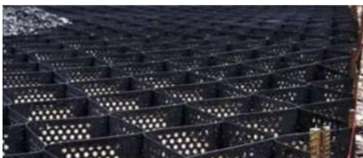
Figura 2.1.2.4 Geoceldas
