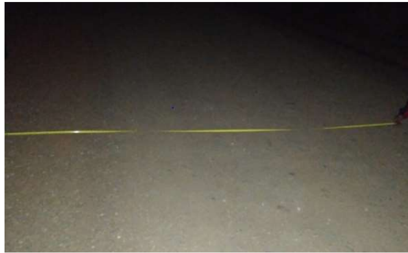
Figura 3.2.4.1 Medición del ancho del tramo.
