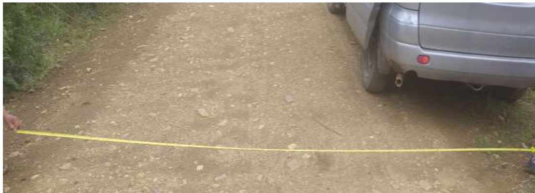
Figura 3.2.1.2 Medición del ancho del tramo.
