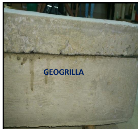
Fig. 4-64. Recapamiento de hormigón con Geogrilla en vigas
