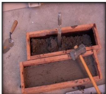
Fig. 4-36. Apisonado la mezcla en las vigas
