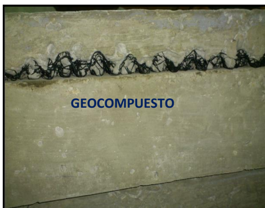
Fig. 4-65. Recapamiento de hormigón con Geocompuesto en vigas
