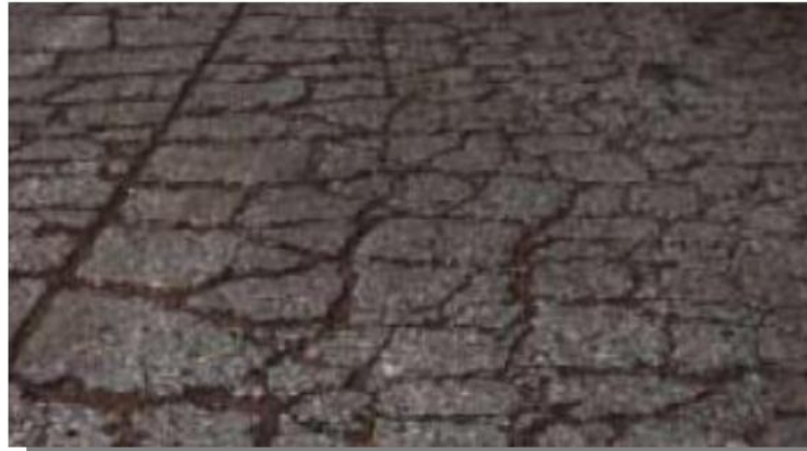
Fig. 3-18 LOSA SUBDIVIDIDA
