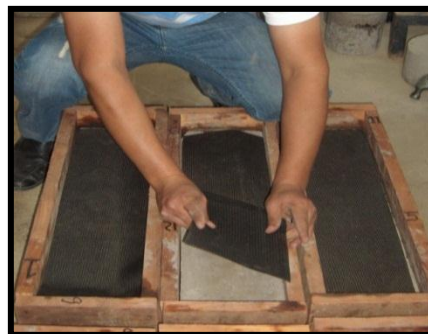
Fig. 4-48. Colocando la geogrilla en las vigas fisuradas
