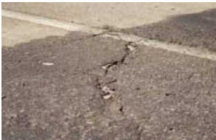
Fig. 3-20 FISURA INDUCIDA
