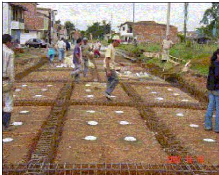
Fig. 3-11 PROCESO CONSTRUCTIVO DE LAS LOSAS CONTINUAMENTE REFORZADO
