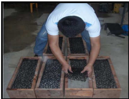
Fig. 4-47. Colocando el geocompuesto en las vigas fisuradas
