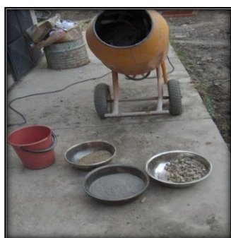
Fig. 4-31 Elaboración de la mezcla de concreto
