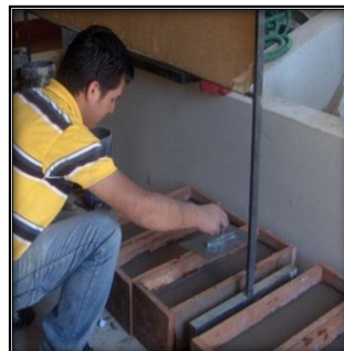
Fig. 4-38. Nivelando la mezcla de concreto
