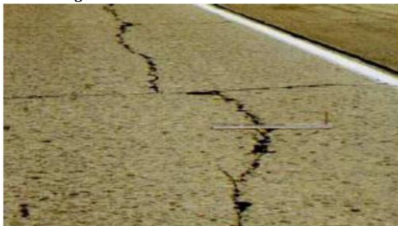
Fig. 3-16 FISURA LONGITUDINAL
