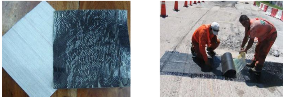
Fig. 3-22 COLOCACIÓN DEL GEOCOMPUESTO COMO ANTI-REFLEJO
