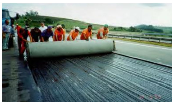
Fig. 3-21 COLOCACIÓN DEL GEOTEXTIL EN EL PAVIMENTO RÍGIDO
